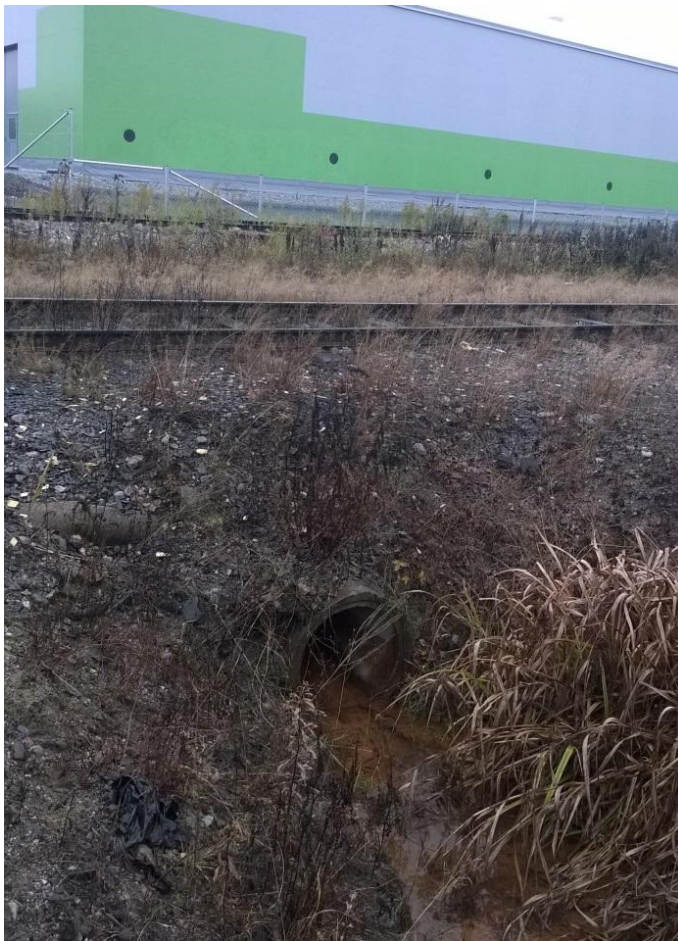
Kuva 4. Radan alittava rumpuputki [Ramboll 10/2017]
