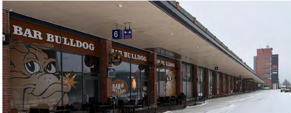
Matkakeskuksen ikkunat avautuvat Eteläiselle Asemakadulle päin.
