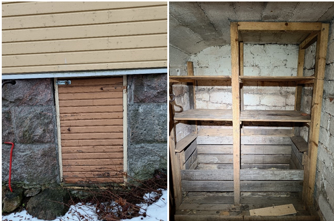
Kuva 4. Kaivokatu 8 kellarin sisäänmeno ja sisätiloja.
