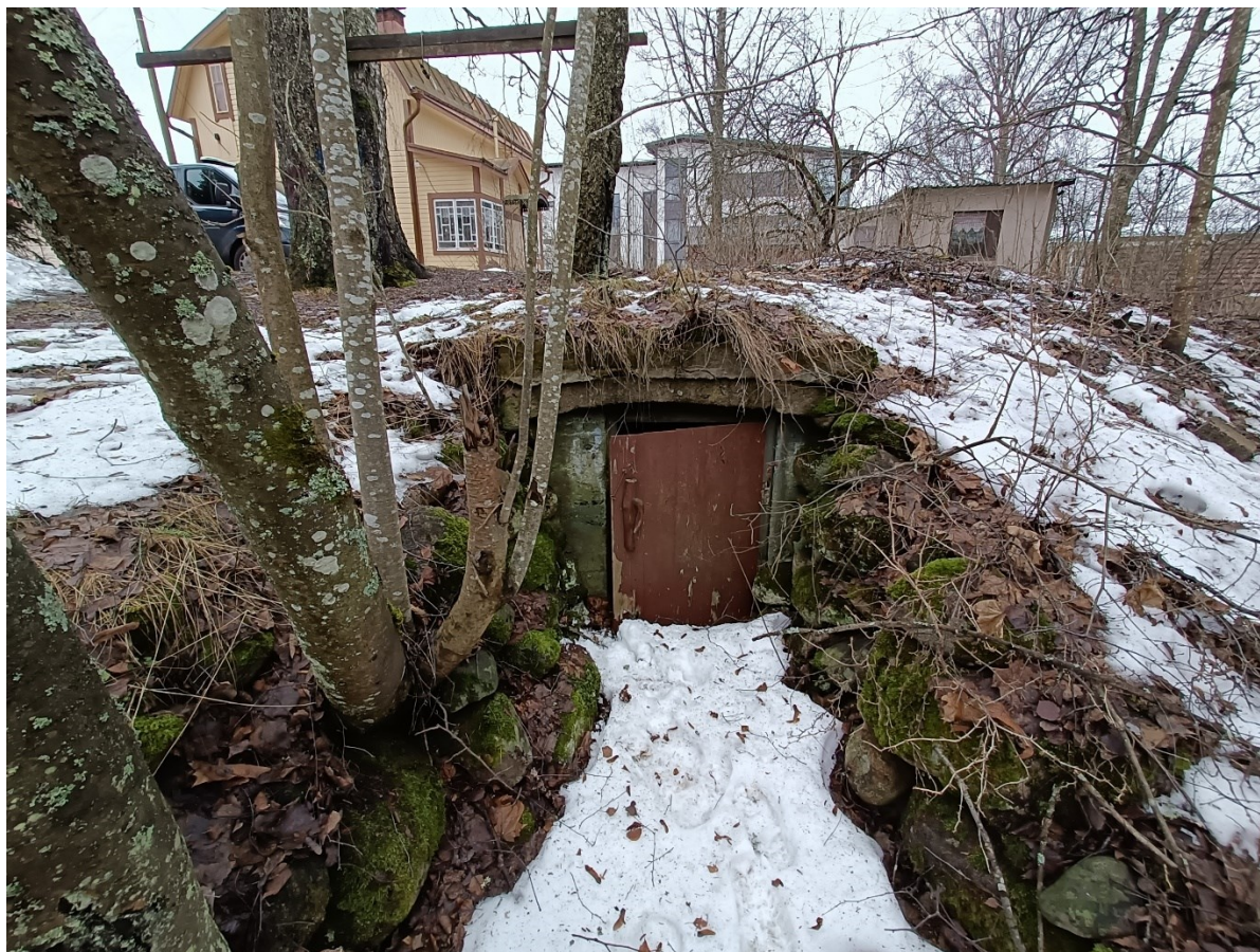
Kuva 2. Kaivokatu 8a sisäänmeno.
