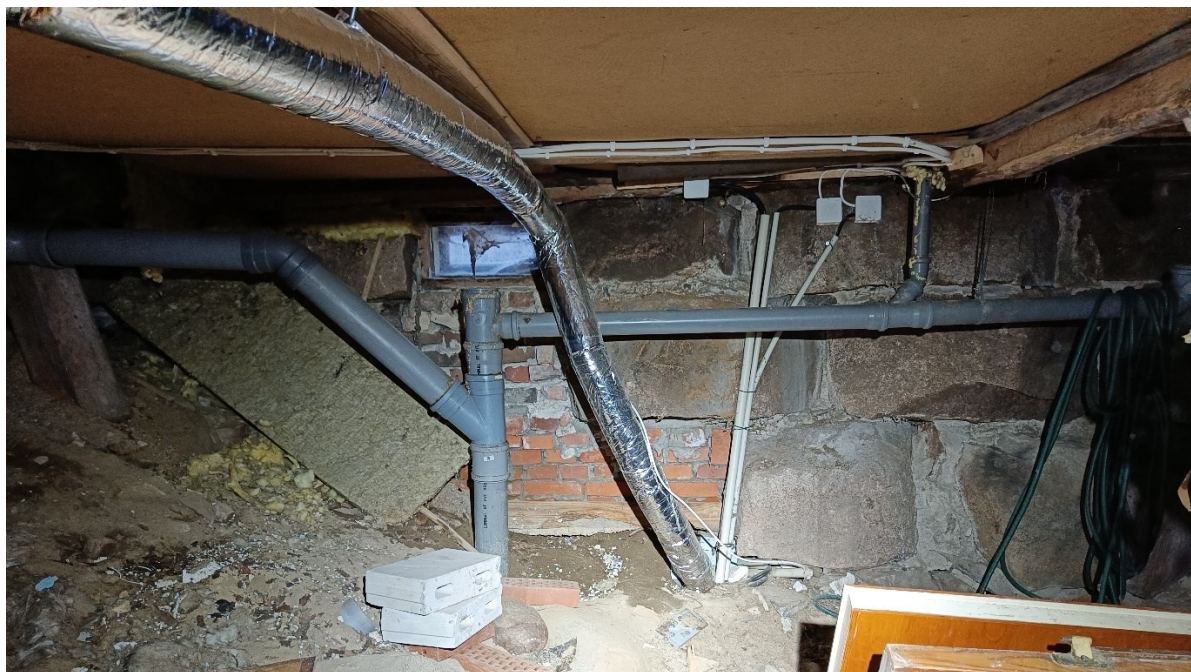
Kuva 5. Kaivokatu 8 kellarin sisätiloja.
