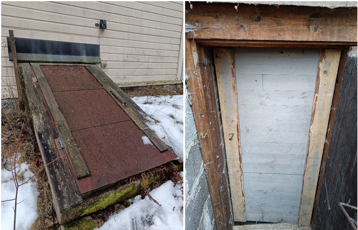
Kuva 7. Kaivokatu 6 kellarin sisäänmeno.
