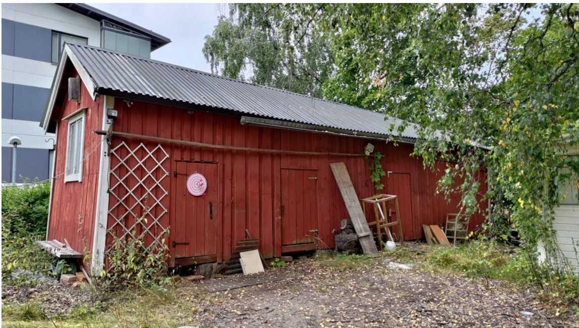
Kuva 5. Kaivokatu 6a:n punainen piharakennus.
