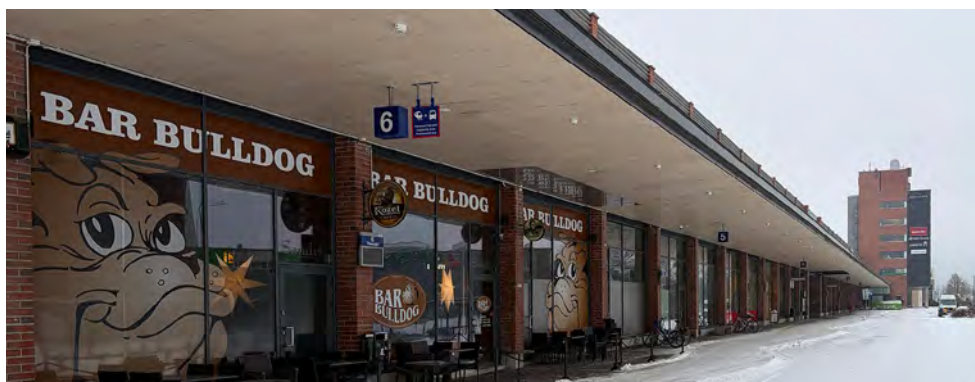
Matkakeskuksen ikkunat avautuvat Eteläiselle Asemakadulle päin.
