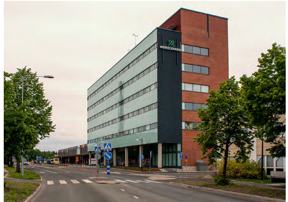
Toimistotorni Eteläiseltä Asemakadulta kuvattuna. Kuva: Arkkitehtitoimisto HKP Oy.
