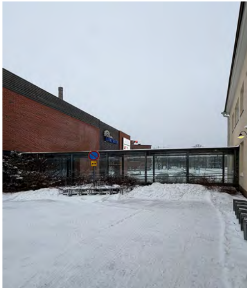
Matkakeskus ja asemarakennus ovat yhteydessä toisiinsa lasisella yhdistunnelilla.
