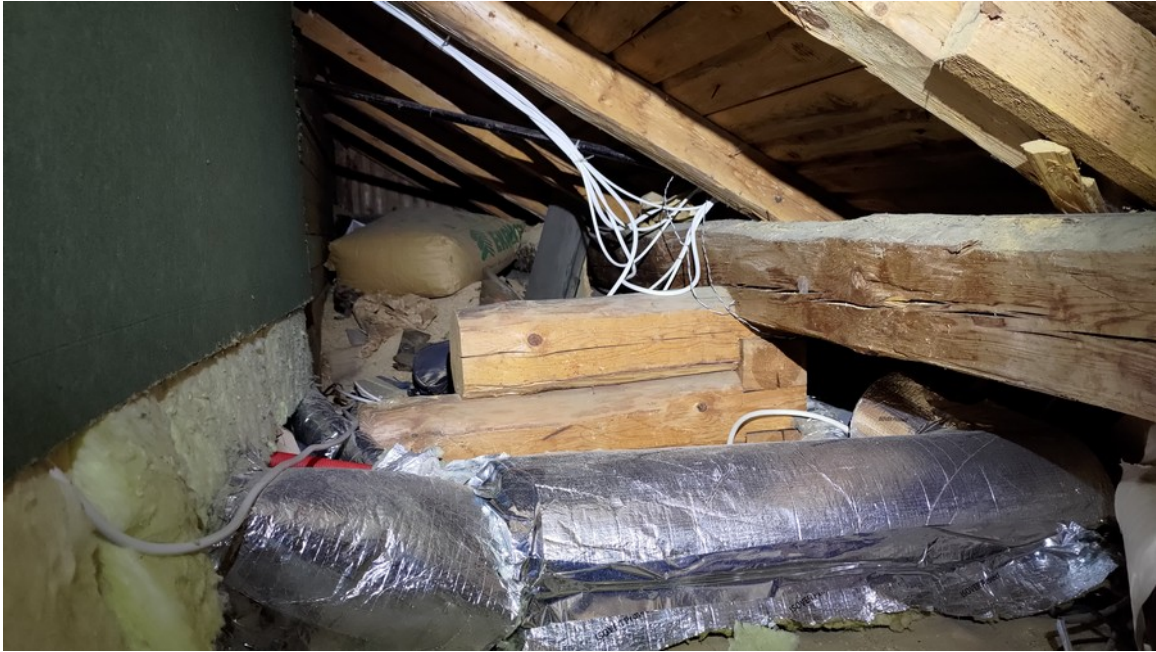
Kuva 10. Kaivokatu 8:n sivuvintti.
