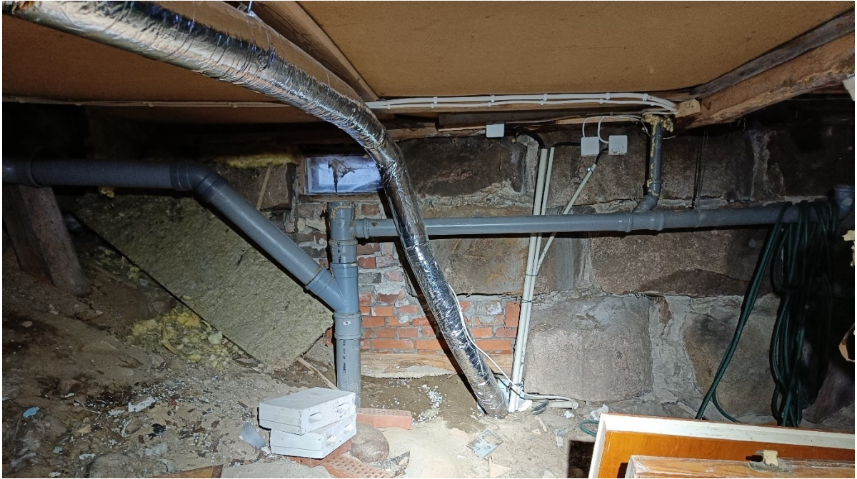
Kuva 5. Kaivokatu 8 kellarin sisätiloja.
