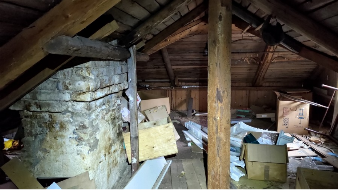
Kuva 6. Kaivokatu 8a päärakennuksen vinttiä.
