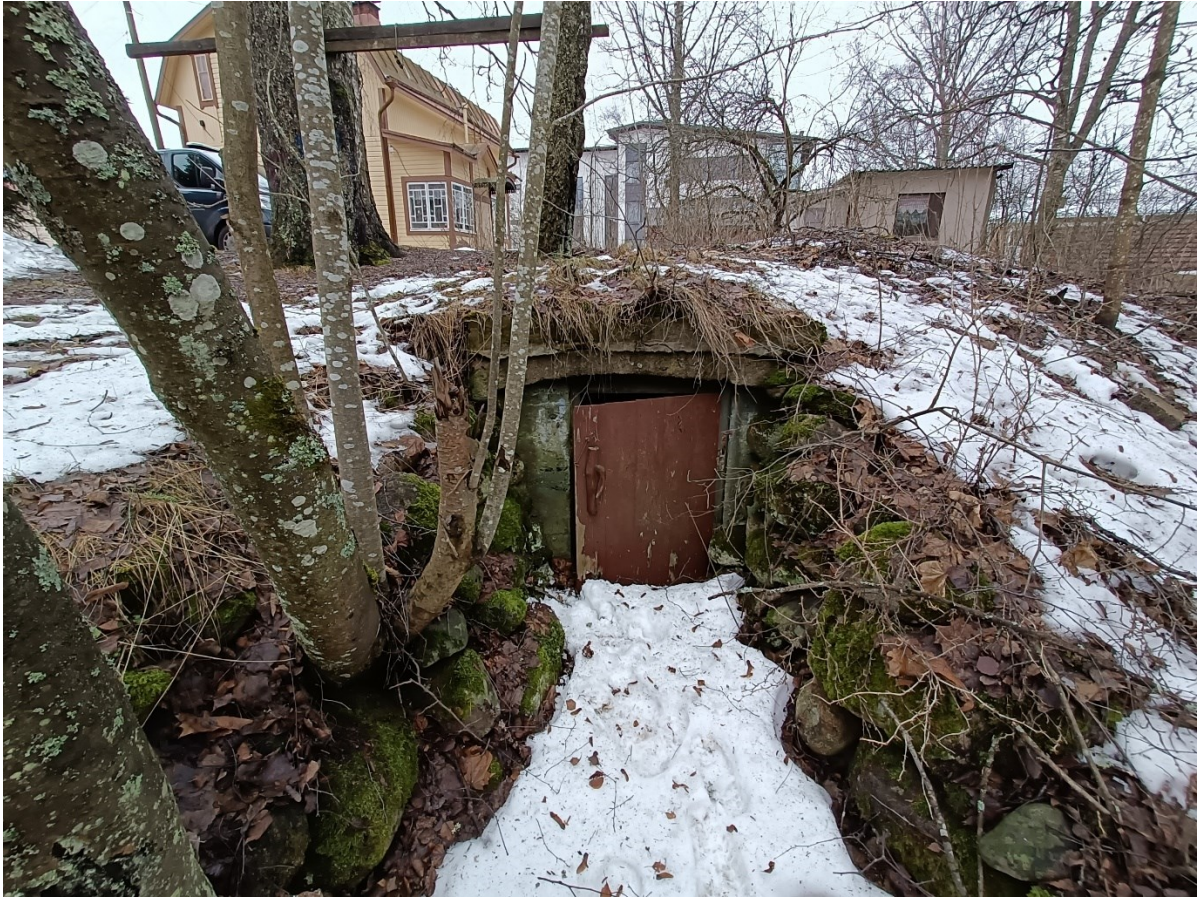
Kuva 2. Kaivokatu 8a sisäänmeno.
