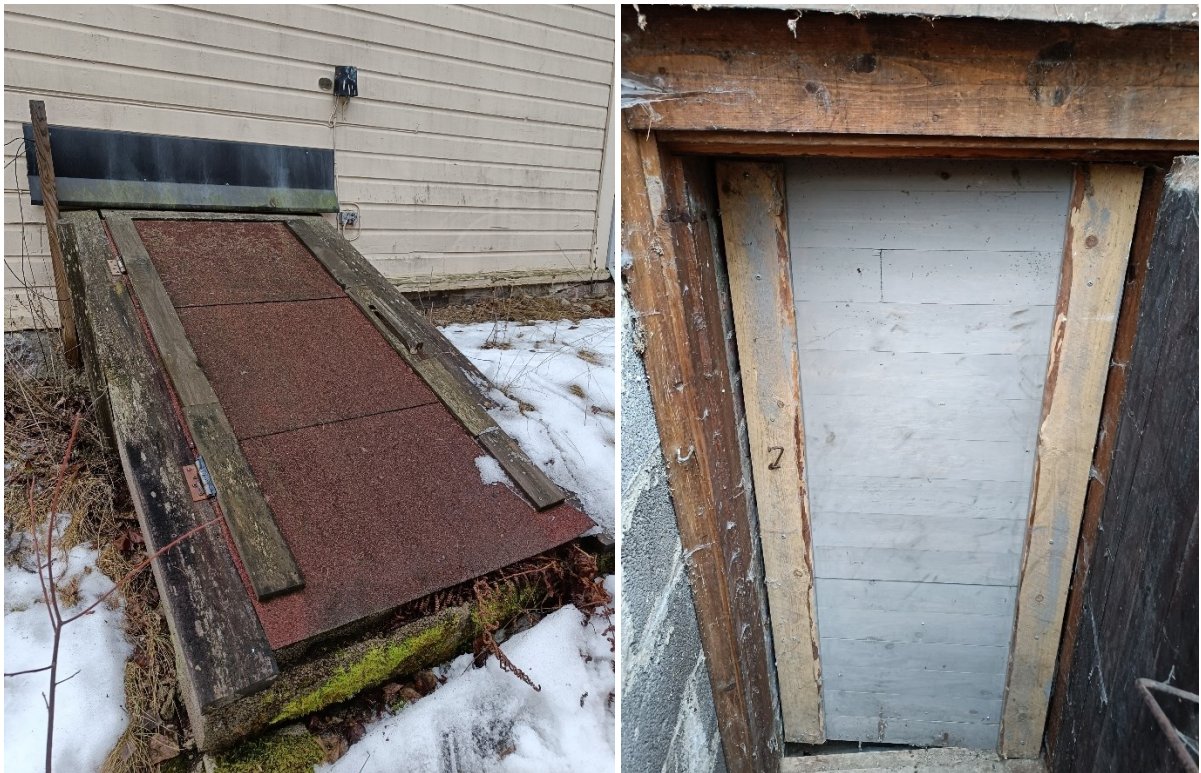
Kuva 7. Kaivokatu 6 kellarin sisäänmeno.
