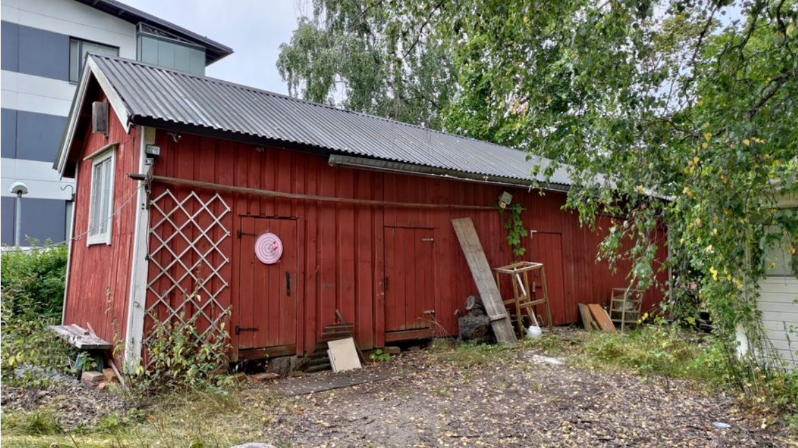
Kuva 5. Kaivokatu 6a:n punainen piharakennus.
