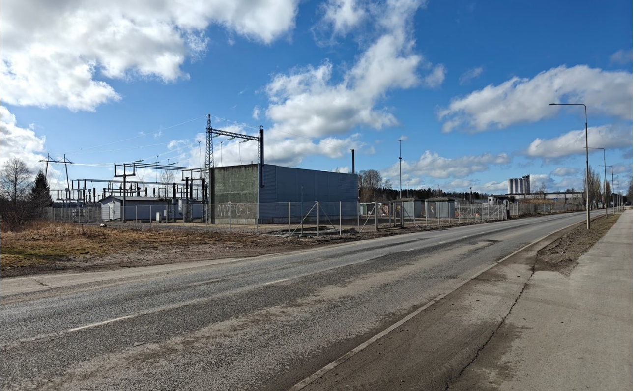
Kuva 27/A: Näkymä Teollisuuskadulta, Parooninmäen teollisuusalueella. Edessä sähköasema ja taustalla oikealla maamerkinä erottuva siilorakennus.
