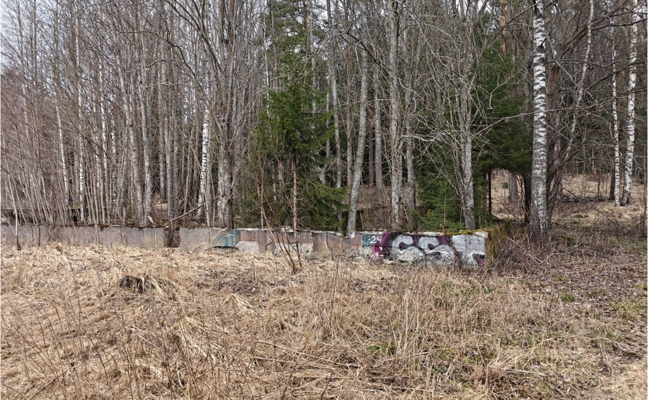
Kuva 41/O: Näkymä Penninmäen eteläreunalta. Kuvassa näkyy vanhan rakennuksen betoninen kivijalka.
