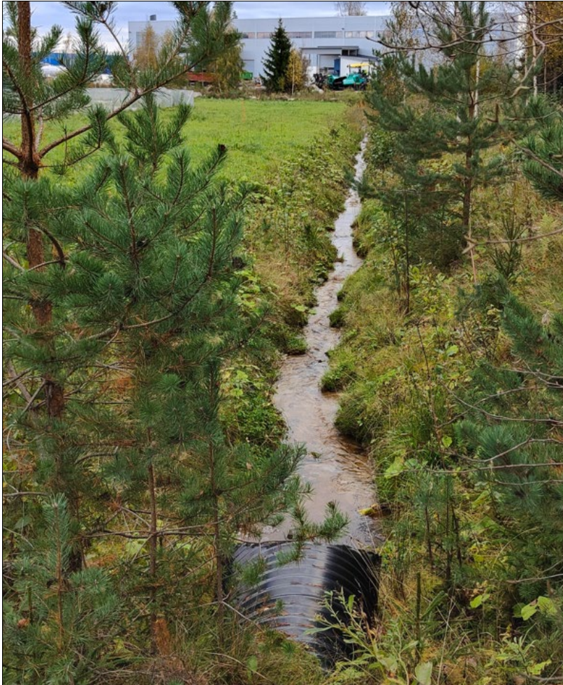
Kuva 15. Suunnittelualan pohjoisrajaa myöden kulkee avo-oja. Oja pohjoisesta etelän suuntaan kuvattuna. (Riihimäen kaupunki, 2023)
