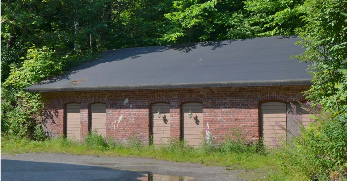
33c, Piippukujan varasto
