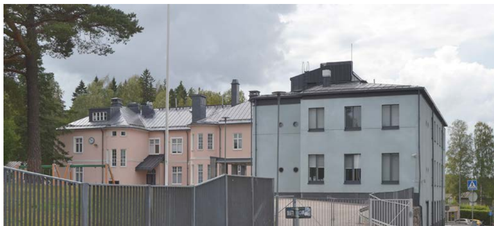
Pohjoisen koulun rakennukset muodostavat historiallisesti ja arkkitehtonisesti kerroksellisen kokonaisuuden Karankadun ja Istuinkiven kulmaan. Koulun vanha, vuonna 1913 rakennettu ja 1928 laajennettu osa on suojeltu asemakaavalla.
