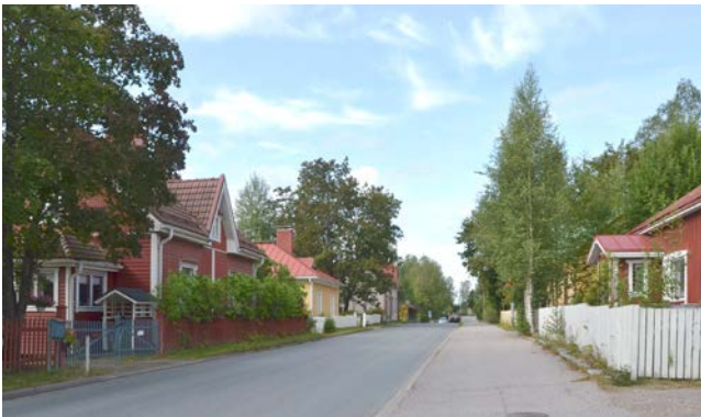
Patastenmäen pientaloalue muodostaa ajallisesti kerroksellisen kokonaisuuden, jossa on säilynyt rakennetun ympäristön kerroksia 1900-luvun alusta.
