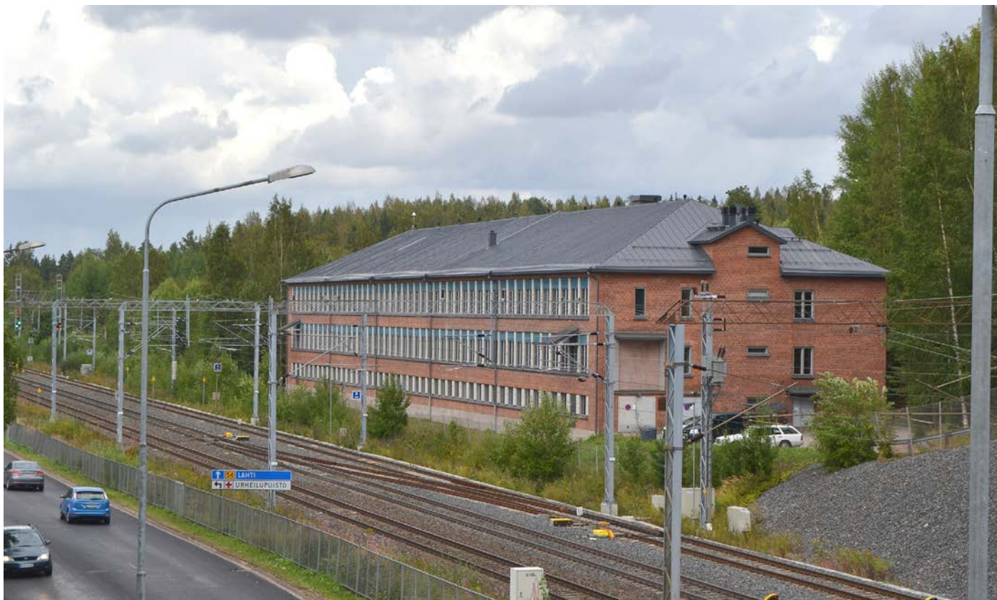
210, entinen Oravan tehdasrakennus.
