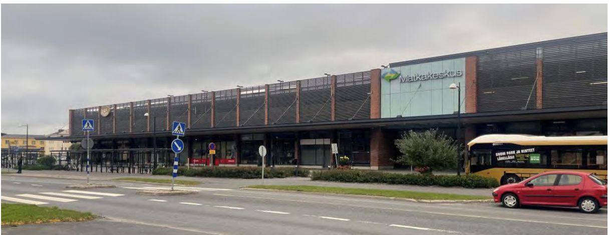
Kuva 5. Matkakeskuksen julkisivu Eteläisen Asemakadun suunnasta (Valokuva: JKMM Arkkitehdit)
