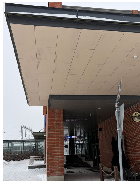
Matkakeskuksen sisäänkäynti rakennuksen pohjoispäädyssä.
