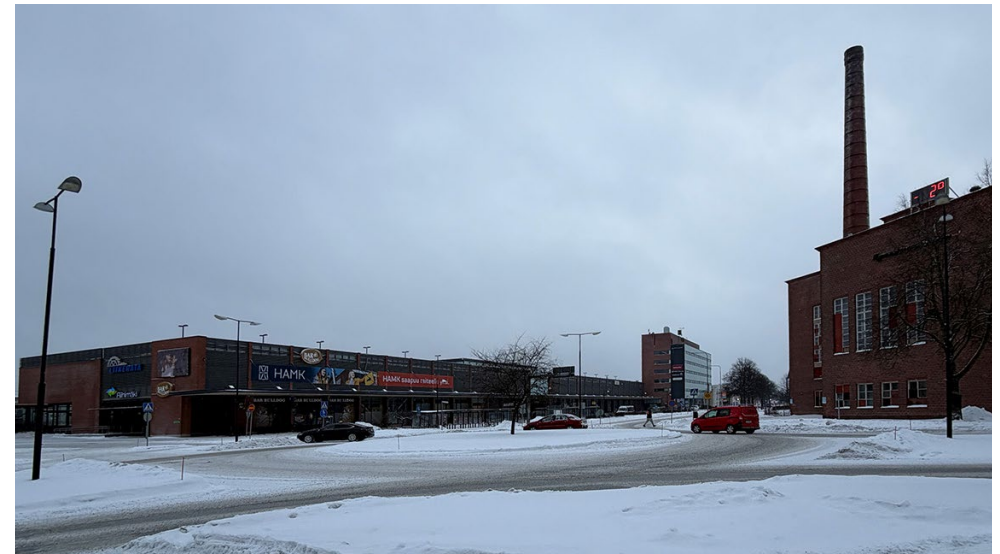
Matkakeskuksen kortteli yhdistyy visuaalisesti materiaalimaailmaltaan ja rakennusmassaltaan osaksi alueen teollista historiaa. Matkakeskus, toimistotorni ja Voimala luovat kaupunkikuvallisen kokonaisuuden.
