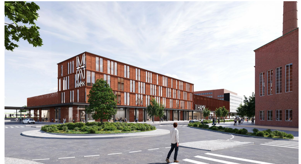
Asemakampuksen uudisrakennus kuvattuna Paloheimonkadulta. Nelikerroksinen laajennus, toimistotorni ja Voimala luovat kaupunkikuvallisesti yhtenäisen kokonaisuuden. Kuva: JKMM, viitesuunnitelma 30.1.2026.
