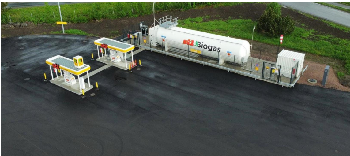
Kuva 23. Esimerkkikuva: Hämeenlinnan littalaan toteutettu biokaasuasema (St1 Oy, 2024).
