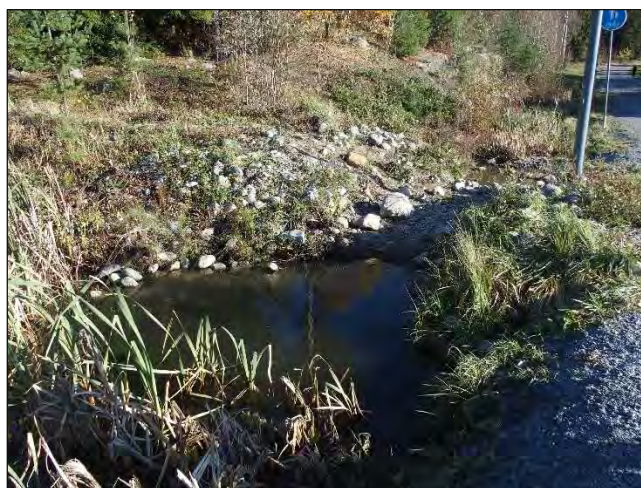
Kuva 20. Esimerkki jalankulku- ja pyöräilyväylän reuna-aojasta, johon on toteutettu pieni allasmainen levitys ja pohjapato. Kiintoaineen poistamista työmaavesistä voidaan edistää vastaavalla rakenteella. Pohjapadon materiaalina tulisi käyttää esimerkiksi salaojasoraa ja louhetta. © Destia Oy 2024.
