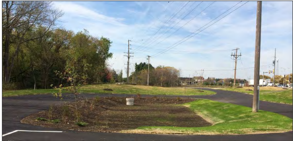
Kuva 18. Esimerkkikuva parkkipaikan yhteyteen toteutetusta hulevesien viivytys- ja imeytysaltaasta, Badger Meter Park in Brown Deer, Wisconsin. Pääosa parkkipaikan hulevesistä kootaan altaaseen. Altaan takaosaan on toteutettu ylivuoto ritiläkaivon kautta. © Aaron Volkening CC BY 2.0.
