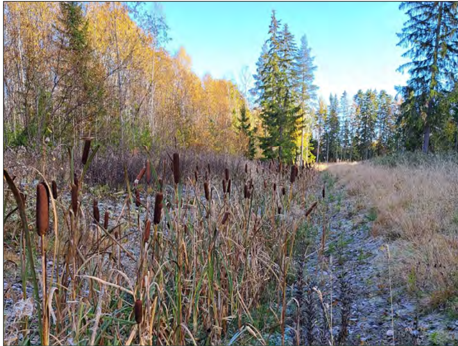
Kuva 15. Esimerkki tulvauomasta Järvenpäästä, kuvaussuunnassa on iso teollisuusalueen hulevesien viivytysallas. Uoman lähtöpisteeseen on toteutettu pohjapato ja uoman luiskien eroosiosuojaus pienlouheella. Uoman pohjalla oleva kasvillisuus hidastaa veden virtausta. © Destia Oy 2024.
