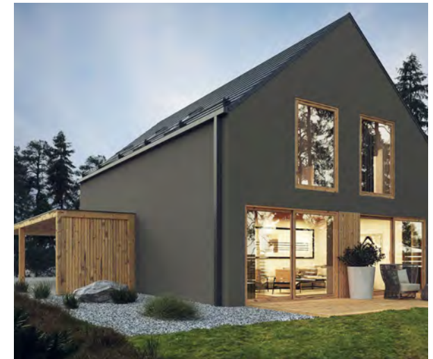
Kuva 26. Esimerkki rapatusta julkisivusta, jossa on mittakaavaa pienentävä katoselementti.
