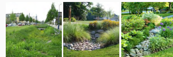
esimerkkejä yhteispihojen hulevesien imeytys- ja viivytyksratkaisusta, sadepuutarhoja ja kivi- ja kasvipäällysteisiä painanteita
