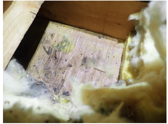
Kuva 40. Kovan mineraalivillan alapinnassa kiinni olleessa pinnoitetussa pahnissa oli kosteusta.
