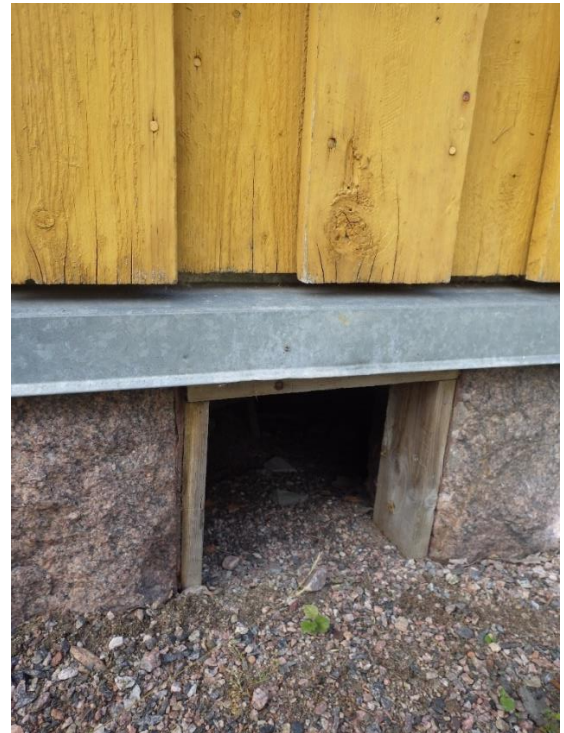
Kuva 10. Maanpinnan tasoa on nostettu tuuletusaukkojen tasolle.
