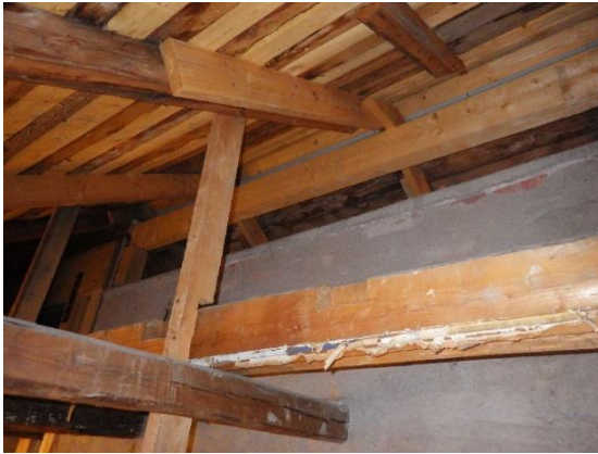
Kuva 76. Vesikaton kannatukseen on tehty muutoksia.
