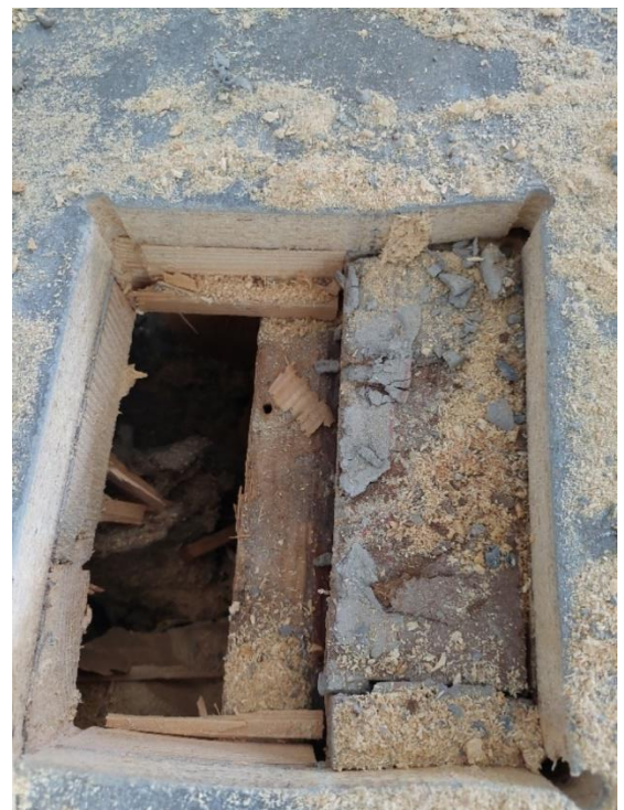
Kuva 56. Lastulevyn alla ovat mahdollisesti alkuperäiset ponttilaudat.
