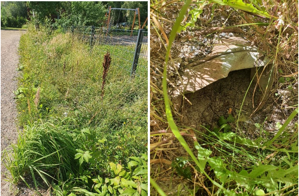
Kuva 5. Asemakaavan eteläreunassa kulkeva oja ja siihen purkava kiintoaineksestä täyttynyt rumpu.
