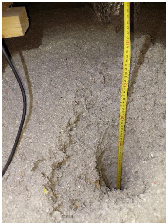
Kuva 74. Yläpohjan eristeenä on selluvillaa.
