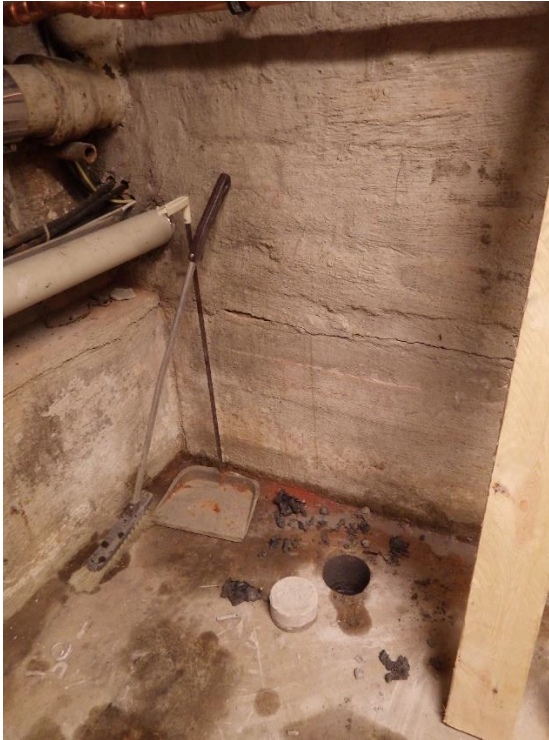
Kuva 22. Pannuhuoneen (tila 002) alapohjaan tehty rakenneavaus RA9. Rakenteessa oli vedeneristeenä tukikuksellinen bitumisively.
