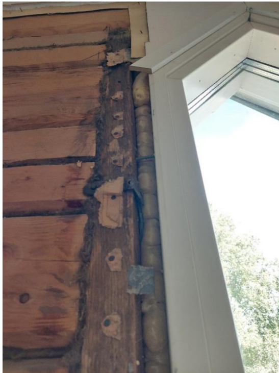
Kuva 65. Vanhan karmin tilkkeenä on pellavarivettä ja uusi karmi on tiivistetty vanhaan uretaanilla.
