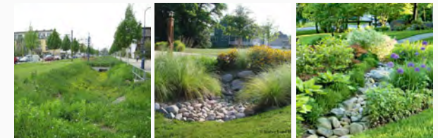
esimerkkejä yhteispihojen hulevesien imeytys- ja viivytysratkaisusta, sadepuutarhoja ja kivi- ja kasvipäällysteisiä painanteita
