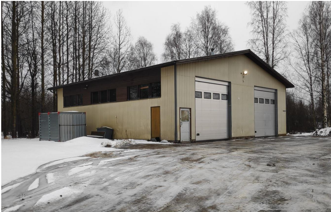
Kuva 10. Riihimäen Kaukolämmön varavoimalaitos kuvattuna Siltakadulta. (Riihimäen kaupunki, 2023)
