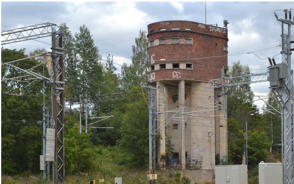
Kuva 12. VR:n vesitorni sijaitsee alueesta itään radan toisella puolella. (Riihimäen kaupunki, 2019)
