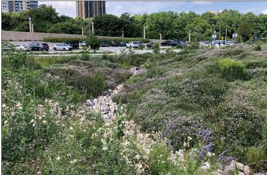
Kuva 13. Esimerkki luonnonmukaisesti muotoillusta avouomasta, johon on toteutettu eroosiosuojaus. Milwaukee, Wisconsin. © Aaron Walkening CC BY 2.0.
