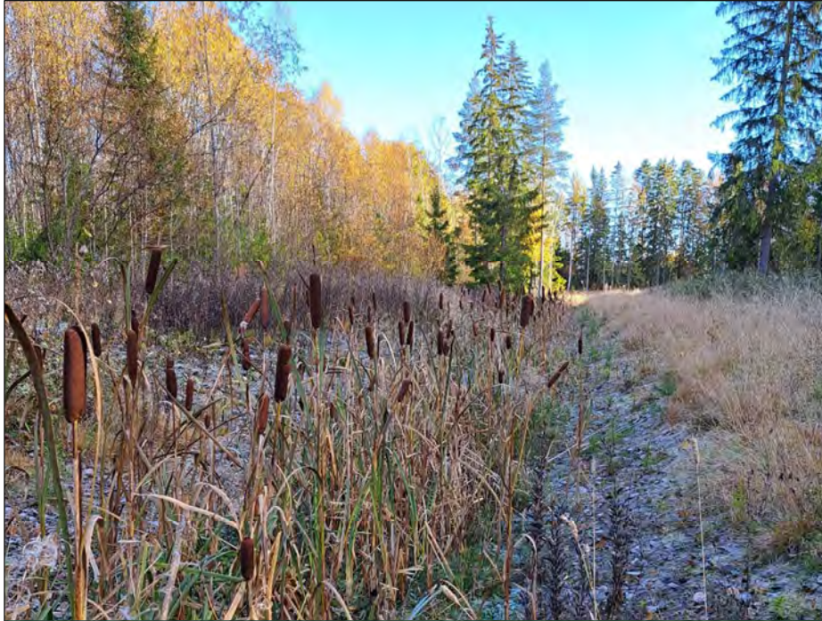
Kuva 15. Esimerkki tulvauomasta Järvenpäästä, kuvaussuunnassa on iso teollisuusalueen hulevesien viivytyksallas. Uoman lähtöpisteeseen on toteutettu pohjapato ja uoman luiskien eroosiosuojaus pienlouheella. Uoman pohjalla oleva kasvillisuus hidastaa veden virtausta. © Destia Oy 2024.
