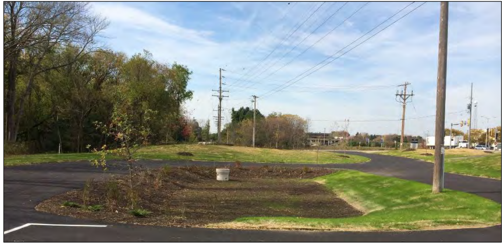
Kuva 18. Esimerkkikuva parkkipaikan yhteyteen toteutetusta hulevesien viivytys- ja imeytysaltaasta, Badger Meter Park in Brown Deer, Wisconsin. Pääosa parkkipaikan hulevesistä kootaan altaaseen. Altaan takaosaan on toteutettu ylivuoto ritiläkaivon kautta. © Aaron Volkening CC BY 2.0.
