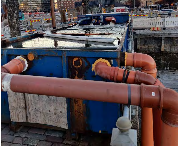
Kuva 21. Hulevesien työmaan aikaiseen viivyttämiseen ja suodattamiseen käytettävä vesitiivis laskeutuskontti. Konttiin pumpataan vedet työmaan kaivannosta. Konttiin on toteutettu väliseiniä hidastamaan veden virtausta ja edistämään kiintoaineksen laskeutumista. Järjestelmässä on kaksi konttia peräkkäin. Jälkimmäiseen konttiin ohjataan vedet ensimmäisen kontin pinnalta. © Destia, 2024.
