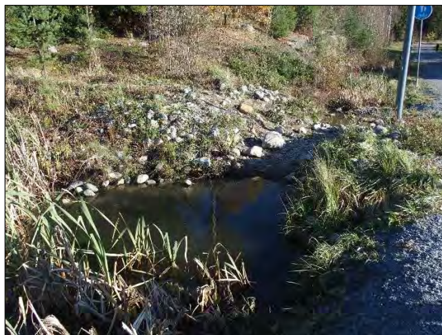
Kuva 20. Esimerkki jalankulku- ja pyöräilyväylän reunaojasta, johon on toteutettu pieni allasmainen levitys ja pohjapato. Kiintoaineksen poistamista työmaavesistä voidaan edistää vastaavalla rakenteella. Pohjapadon materiaalina tulisi käyttää esimerkiksi salaojasoraa ja louhetta. © Destia Oy 2024.
