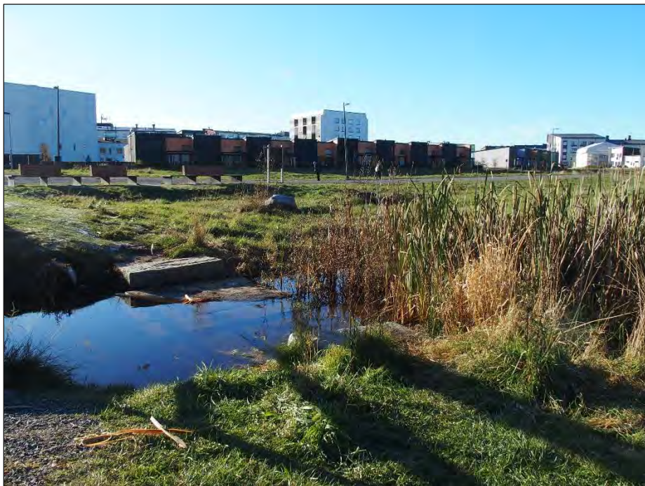
Kuva 14. Esimerkki hulevesiuomaan paasikivin toteutetusta pohjapadosta. Kun vesimäärät uomassa ovat vähäisempiä, toimii pohjapato siltana. © Destia Oy 2024.
