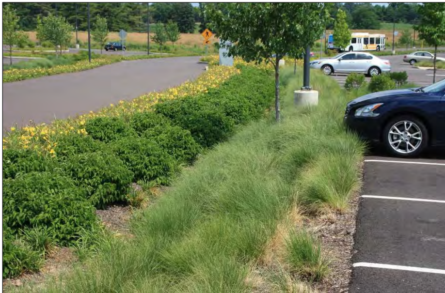
Kuva 12. Esimerkki hulevesien imeyttämiseen käytetystä viherkaistasta. Hulevedet imeytetään maaperään kaistan vesijuoksun kohdalta. Vesijuoksun kohdalla rakennekerrokset ovat hyvin vettä läpäiseviä. Pohjalle on toteutettu suodatuskerros hiekasta. Maaperä on hyvin vettä läpäisevää. © Montgomery County Planning Commission CC BY 2.0.
