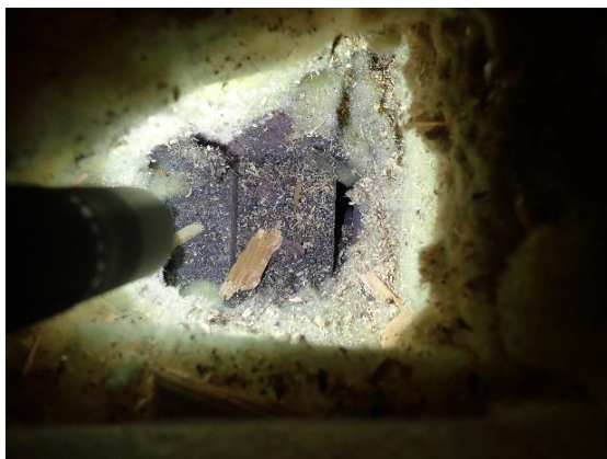
Kuva 35. Aluslaudat olivat tummuneet ja laudoitus ei ollut yhtenäinen.
