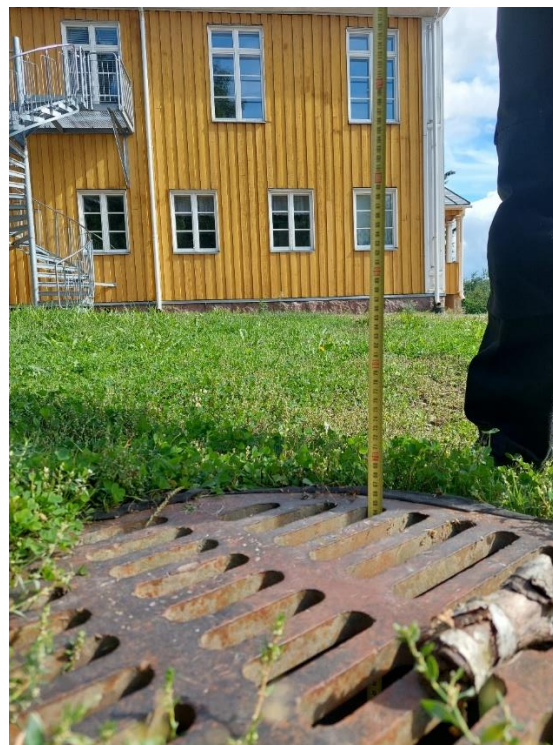
Kuva 12. Länsipuolen kattovedet ohjataan hulevesikaivoon, jossa vedenpinnan taso on lähellä kellarin lattian tasoa.
