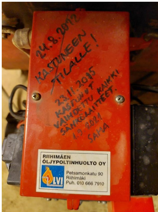
Kuva 20. Kellariin on noussut vettä useina vuosina syksyisin.
