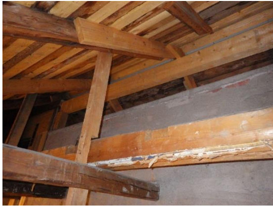
Kuva 76. Vesikaton kannatukseen on tehty muutoksia.
