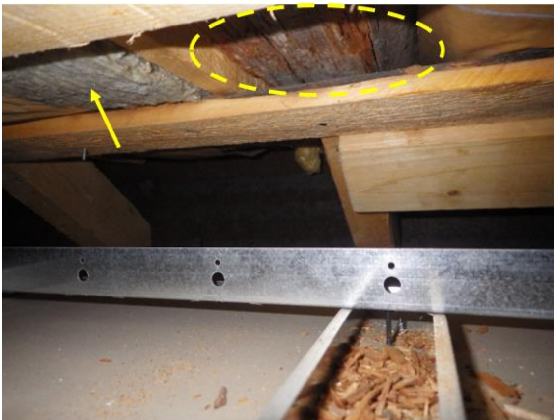
Kuva 54. Välipohjan sisältä otetussa kuvassa näkyy välipohjapalkin alapinnalla lahoa. Mineraalivillaeristeiden alla ei ole paperia kaikissa kohdissa (nuoli).
