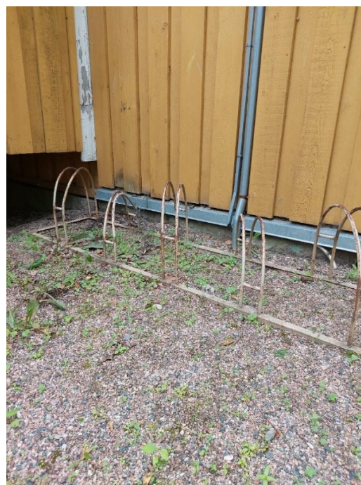
Kuva 72. Sokkeli on paikoin hyvin matala ja laudoituksen alapinnassa oli roiskeveden aiheuttamia vaurioita.
