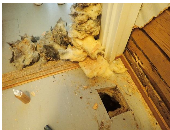
Kuva 34. Mineraalivillassa oli runsaasti tummumaa. Villakerrosten välissä oli puupurua.
