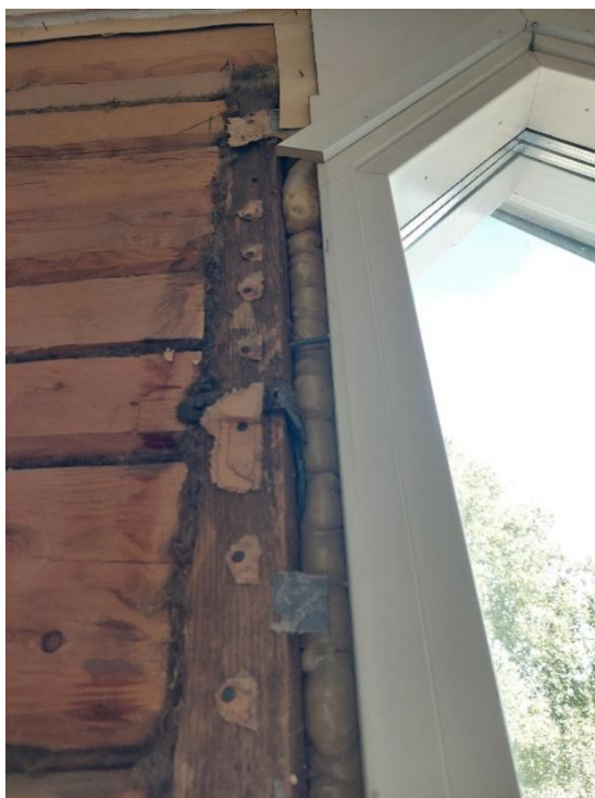
Kuva 65. Vanhan karmen tilkkeenä on pellavarivettä ja uusi karmi on tiivistetty vanhaan uretaanilla.
