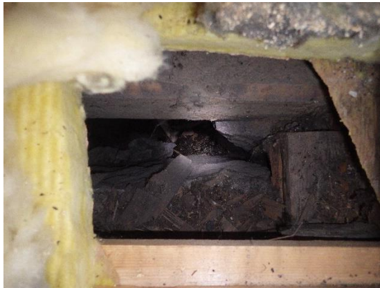
Kuva 41. Ryömintätilan nurkassa maapohja oli noin 0,5 m alempana kuin piha-alueen maanpinnan taso. Pohjalla oli runsaasti, sekalaista, osin maatunutta mujua.
