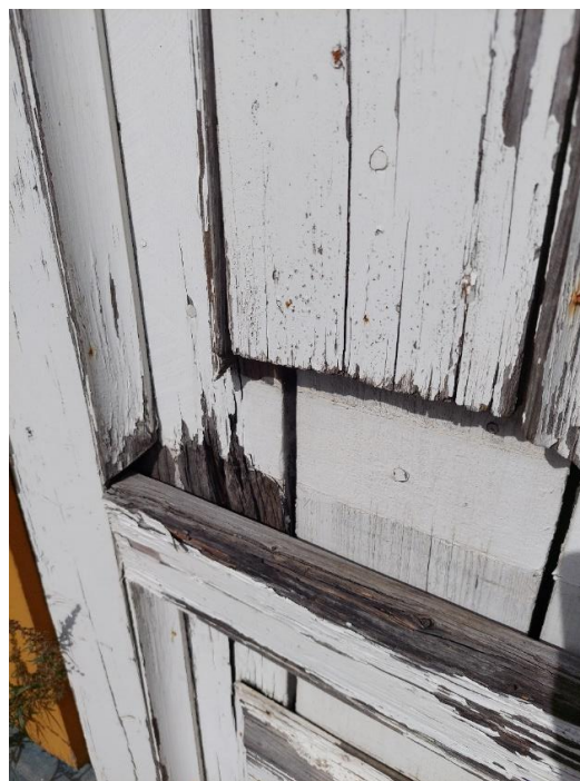
Kuva 70. Nurkkien koristepanelointien maali on kulunut pois, pinta on harmaantunut ja paikoin lahovaurioitunut.
