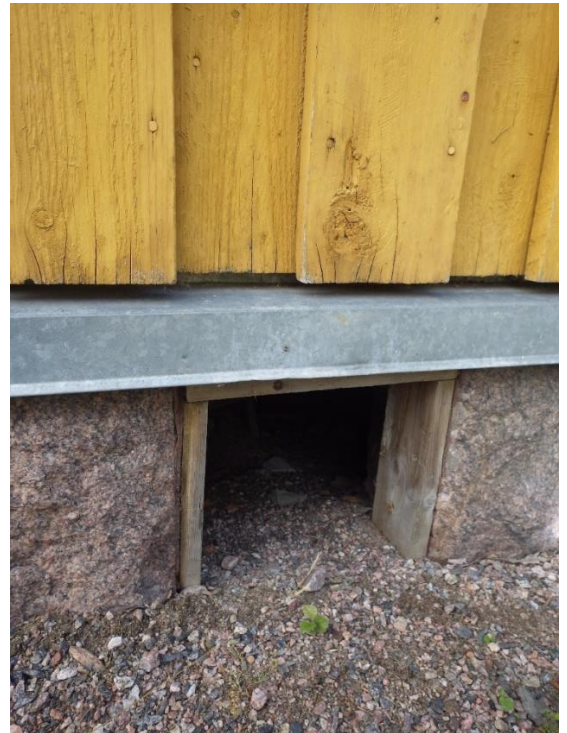
Kuva 9. Tontin pohjoispuolella on n. 2–3 m korkea muuri, jonka päällä kulkee Erkyläntie. Kuva 10. Maanpinnan tasoa on nostettu tuuletusaukkojen tasolle.
