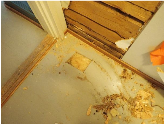
Kuva 33. Alapohjan eristeenä oli mineraalivillaa.
