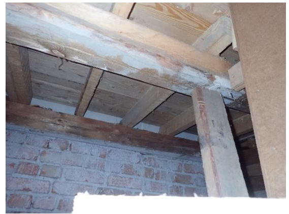
Kuva 48. Levytyksen takaa näkyi ylemmän kerroksen porrashuoneen lepotaso.
