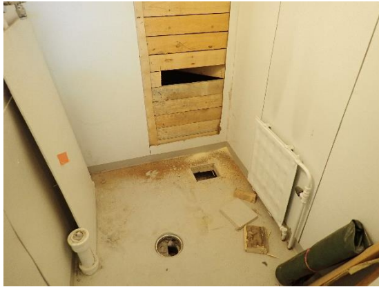
Kuva 45. Varastoon tila 119 tehtiin avaus alapohjaan (RA7) ja seinän levytykseen (RA 8).
