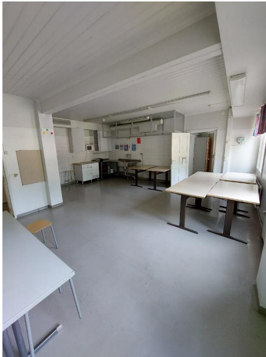
Kuva 27. Yleiskuva 1. kerroksen keittiöstä. Lattiapäällysteenä on muovimatto, tilassa on lattiakaivo.
