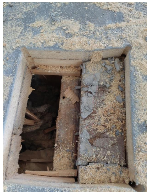
Kuva 56. Lastulevyn alla ovat mahdollisesti alkuperäiset ponttilaudat.
