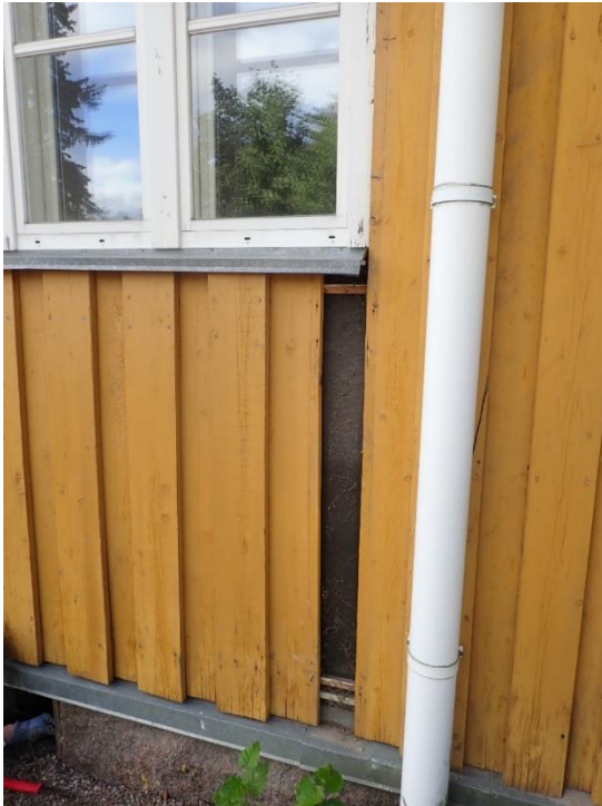
Kuva 67. Ulkoseinän tuulensuojana on bitulit-levy.
