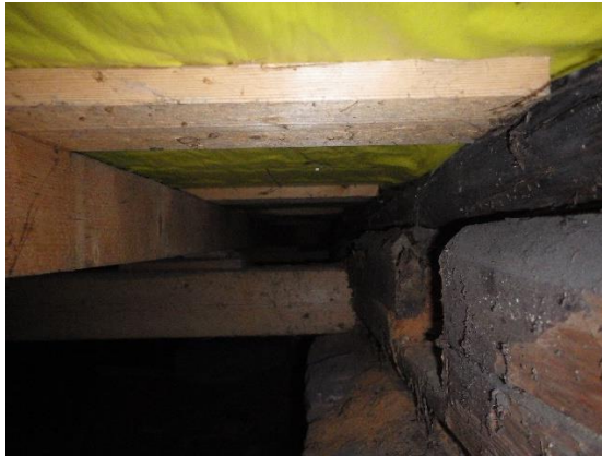
Kuva 43. Uusi alapohja tukeutuu luonnonkivisokkeliin. Vanhoja alapohjan palkkeja oli osin poistettu ja korvattu uusilla.
