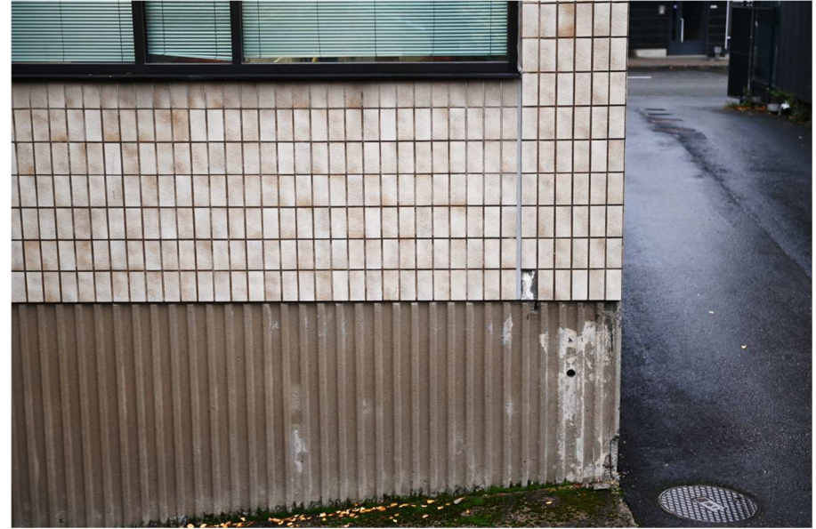
Kuva: Julkisivut ovat kauttaaltaan verhoiltu vaalein klinkkerein. Sisäpihan puolella korkeaksi nousevan sokkelin pinta on pystyuritettu ja maalattu.
