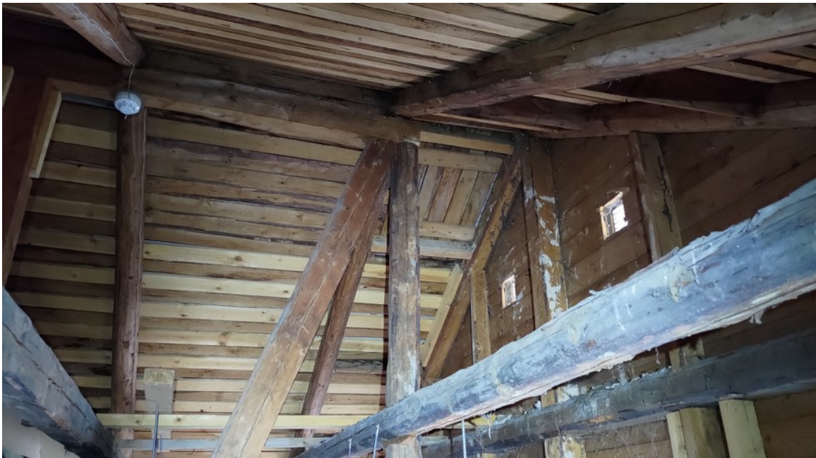
Kuva 2. Patastenmäen koulun kattorakennetta vintin sisältä kuvattuna.
