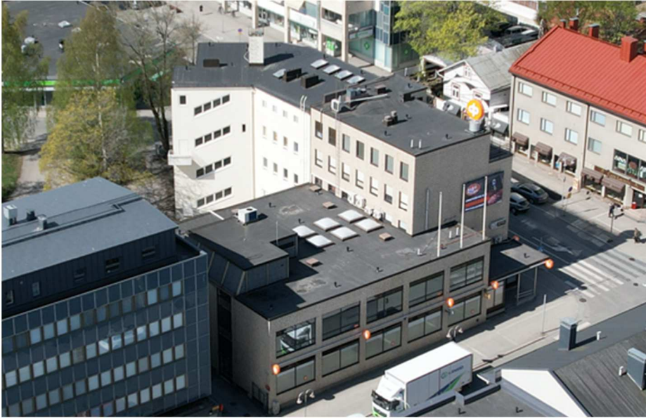
Kuva: Rakennuksen tasakatolla on teknistä tilaa ja kupuikkunoita. Kolme lipputankoa.
