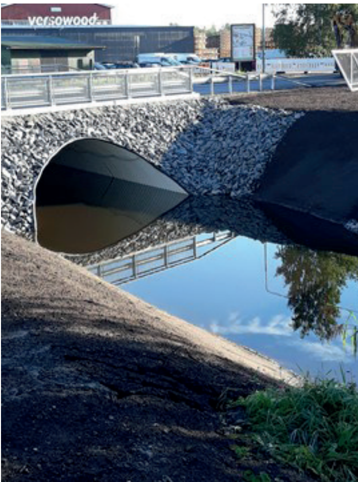
Kuva 8. Teollisuuskadun uusi siltarumpu. (Hämeen ELY-keskus 2020)
