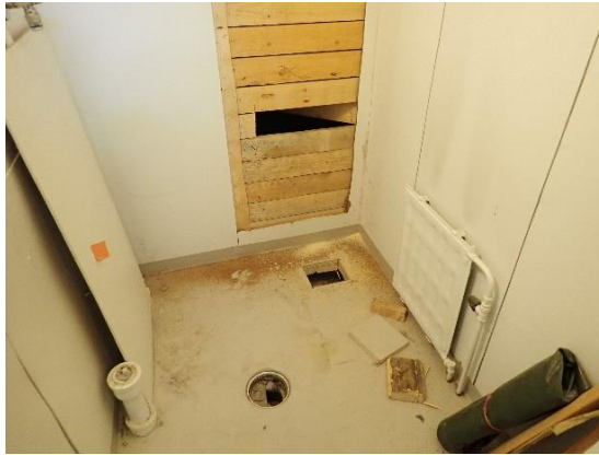
Kuva 45. Varastoon tila 119 tehtiin avaus alapohjaan (RA7) ja seinän levytykseen (RA 8).
