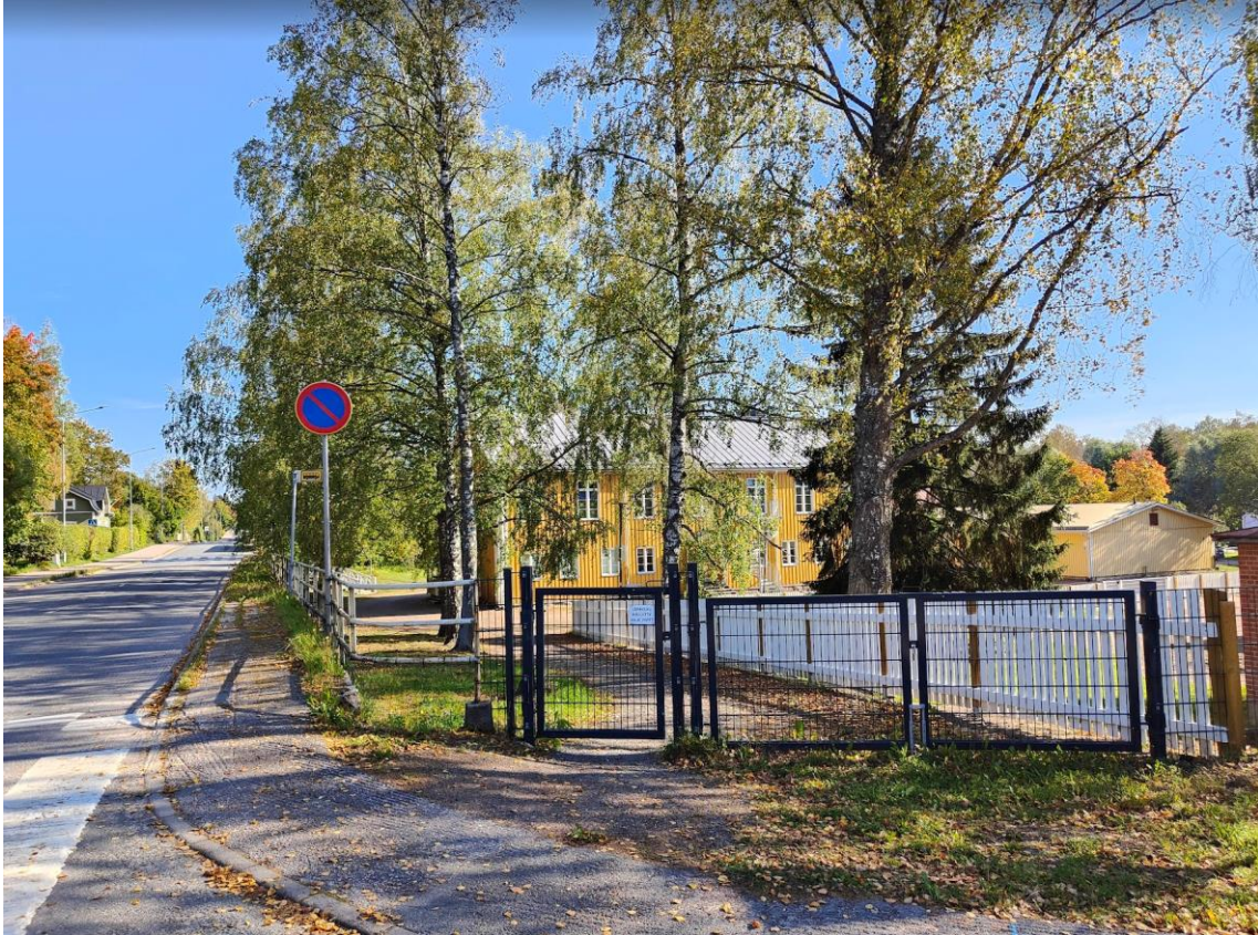
Kuva 6. Kuva Erkyläntien ja Soittajankadun risteyksestä. Vanha puukoulu erottuu katukuvassa puiden lomasta.
