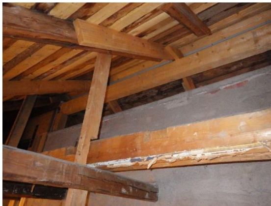
Kuva 76. Vesikaton kannatukseen on tehty muutoksia.
