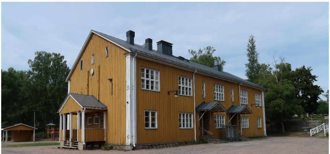
Kuva 5. Koulu nykyisessä asussaan. Kaarevien oviaukkojen päällä on katokset, ikkunoiden puitejako on säilytetty, mutta detaljointi on muuttunut.
