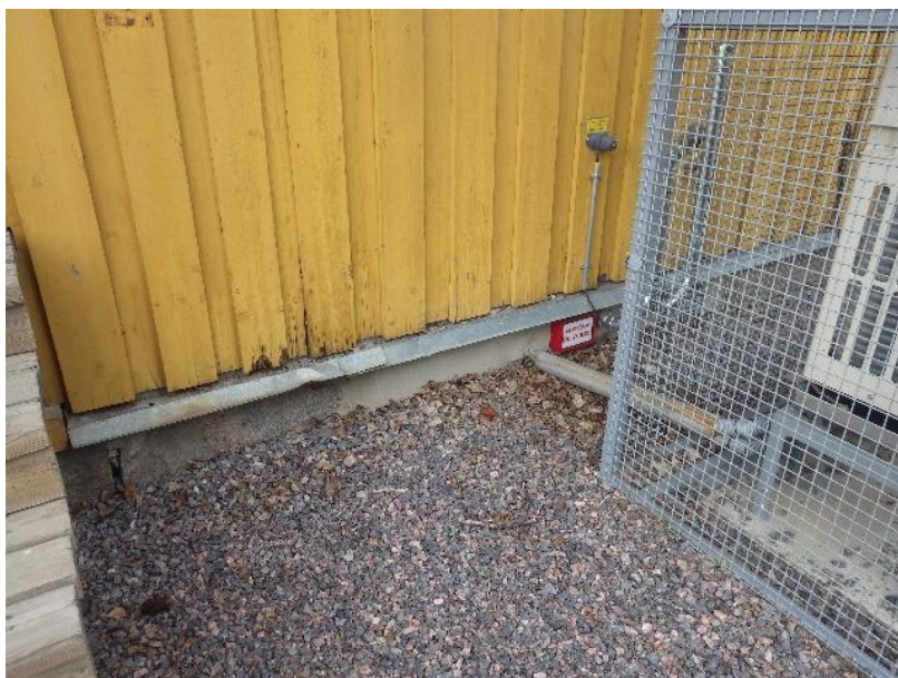
Kuva 13. Kellarin kohdalla perustukset ovat betonirakenteisia, maanpinta rakennuksen vierustalla on tasainen. Julkisivun paneloinnin alaosa on todennäköisesti roiskeveden aiheuttamia vaurioita.
