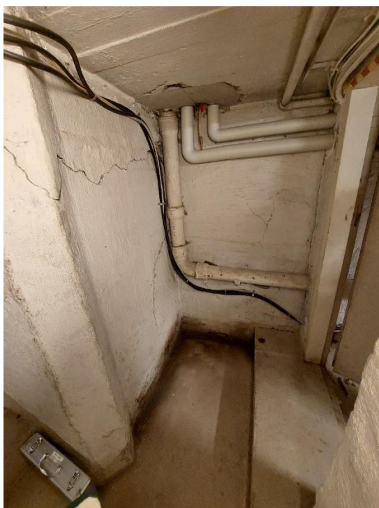
Kuva 15. Porrashuoneen seinissä oli halkeilua. Seinien alaosissa ja alapohjassa todettiin kohonneita pintakosteuden vertailulukemia.
