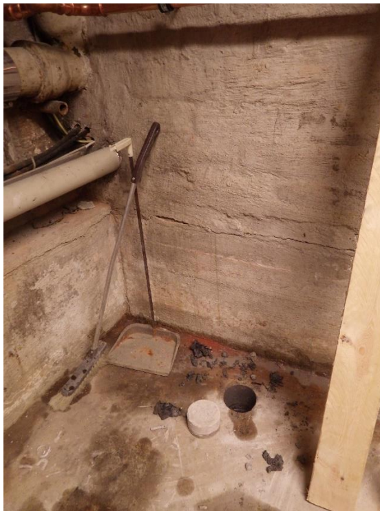
Kuva 22. Pannuhuoneen (tila 002) alapohjaan tehty rakenneavaus RA9. Rakenteessa oli vedeneristeenä tukikudoksellinen bitumisively.
