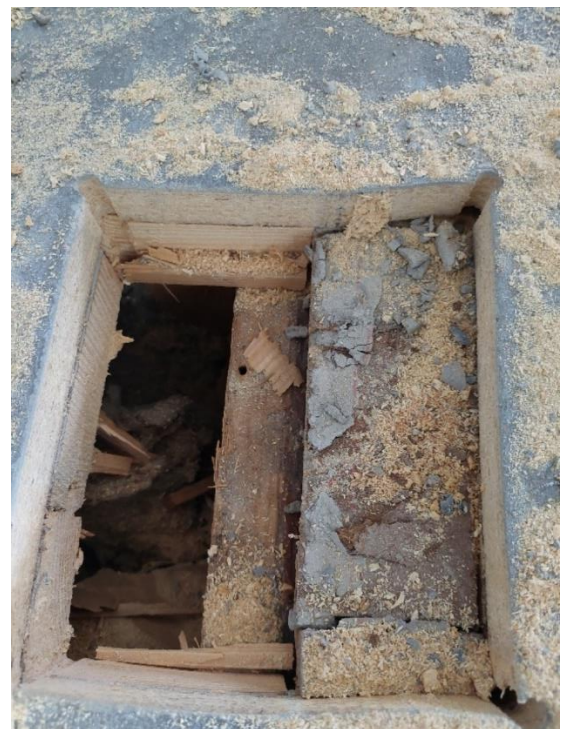
Kuva 56. Lastulevyn alla ovat mahdollisesti alkuperäiset ponttilaudat.
