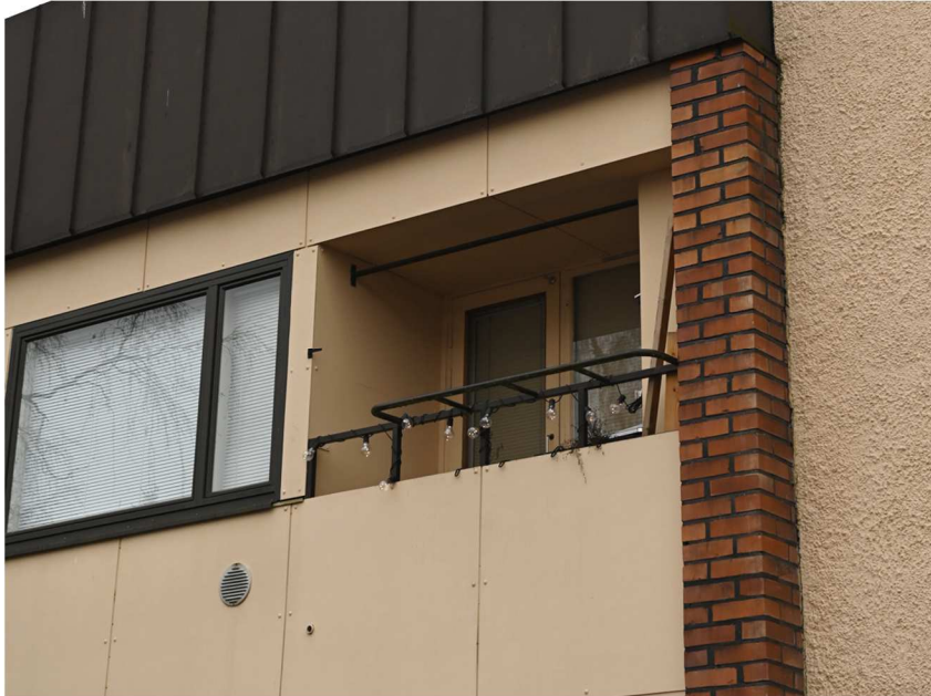
Kuva: Laajennusosan parveke ja levyverhousa.
