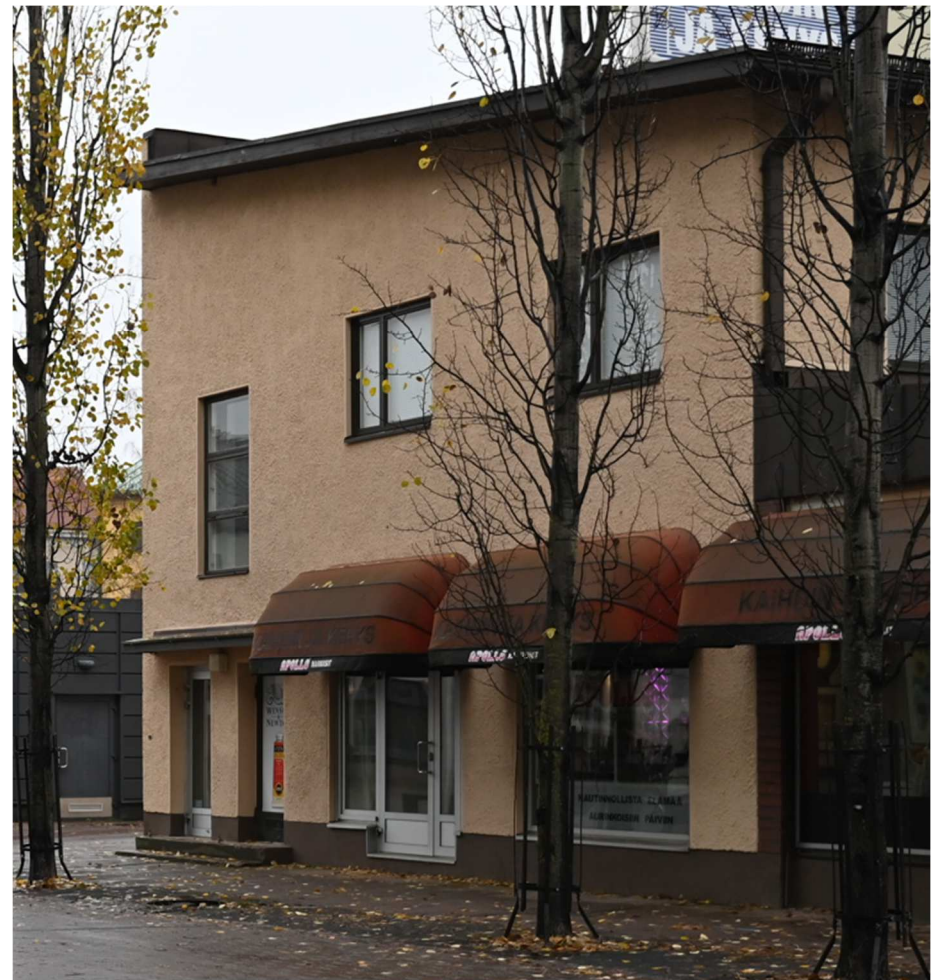
Kuva: Julkisivu luoteeseen eli Välikadulle syksyllä 2022. Käytössä olevissa kahdessa sisäänkäynnissä on samanlaiset uudet lasiovet. Keskimmäisestä ovi ei ole käytössä.
