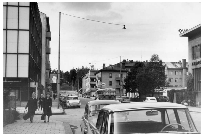
Kuva: Keskuskadun jalkakäytävät on päällystetty betonilaatoilla. Jalkakäytäviä on sittemmin levennetty. [Kuva n. 1960- ja 70-lukujen vaihe.] / Riihimäen kaupunginmuseon valokuvakokoelmat.
