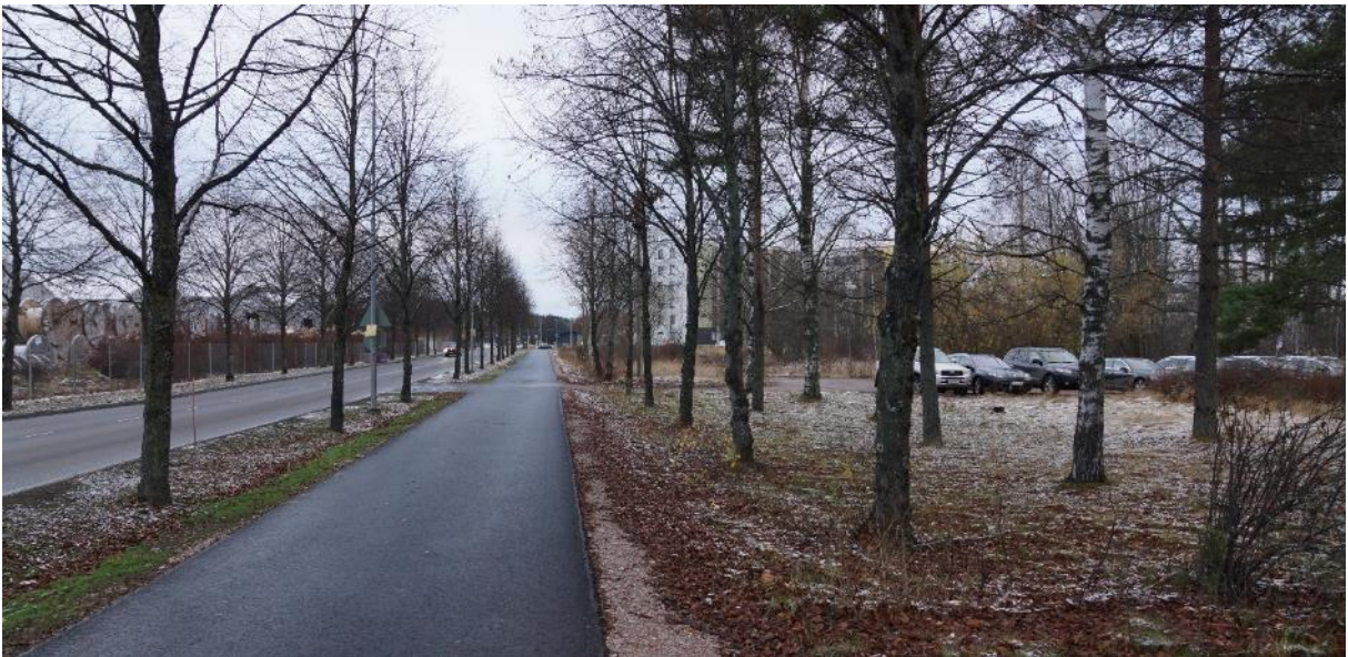
Kuva 3. Näkymä Kulmalan puistokadulta länteen. Kuva: Sweco, 11/2022.
