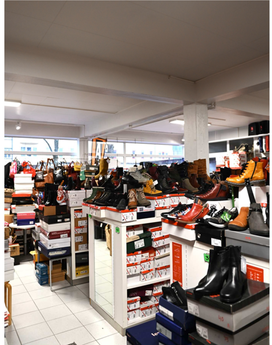
Kuva: Entisessä autohallissa on näkyvissä betonirakenteet: massiivilaattaa kannattelevat pilarit ja palkit.
