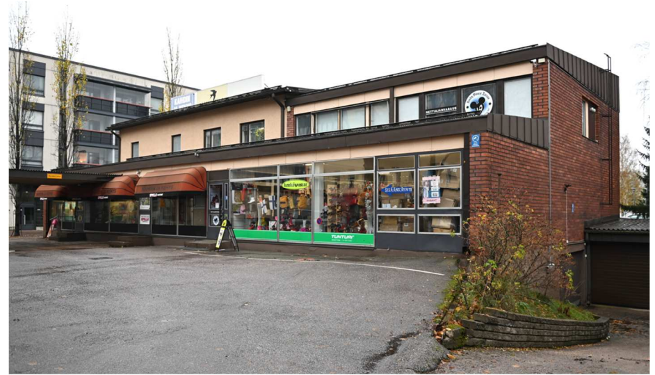
Kuva: Julkisivu lounaaseen eli Keskuskadulle syksyllä 2022. Lisärakennukseen ei ole tehty suurempia julkisivumuutoksia. Entisen autoliikkeen kohdalla on vanhat isot hallinovat.
