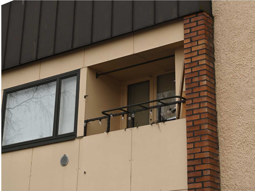
Kuva: Laajennusosan parveke ja levyverhousa.
