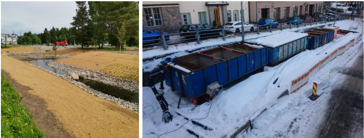
Kuva 7. Uoman eroosiosuojaus (vas.) ja konttikäsittely (oik.).
