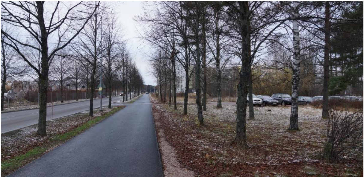
Kuva 3. Näkymä Kulmalan puistokadulta länteen. Kuva: Sweco, 11/2022.
