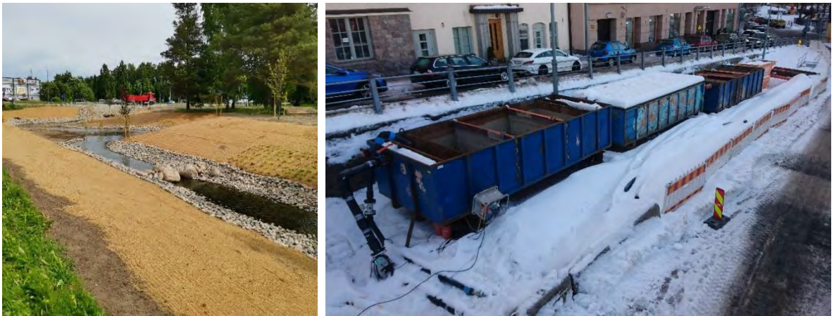
Kuva 7. Uoman eroosiosuojaus (vas.) ja konttikäsittely (oik.).
