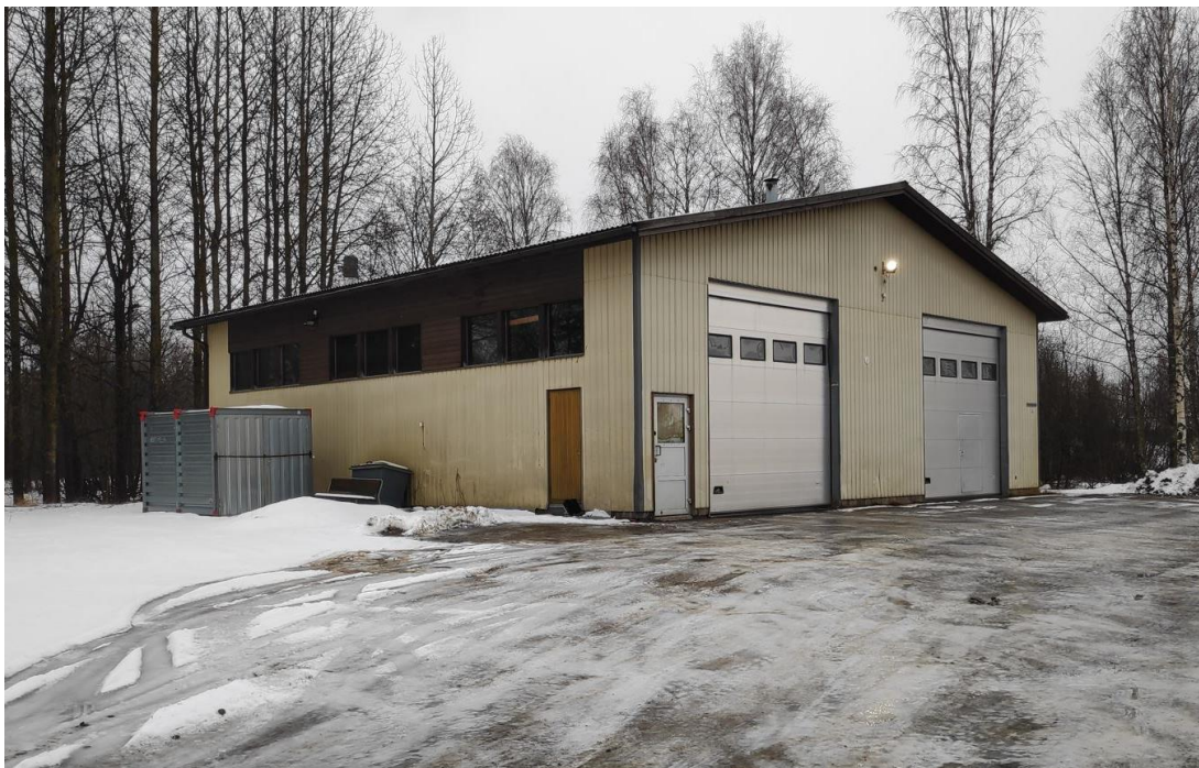
Kuva 10. Riihimäen Kaukolämmön varavoimalaitos kuvattuna Siltakadulta. (Riihimäen kaupunki, 2023)
