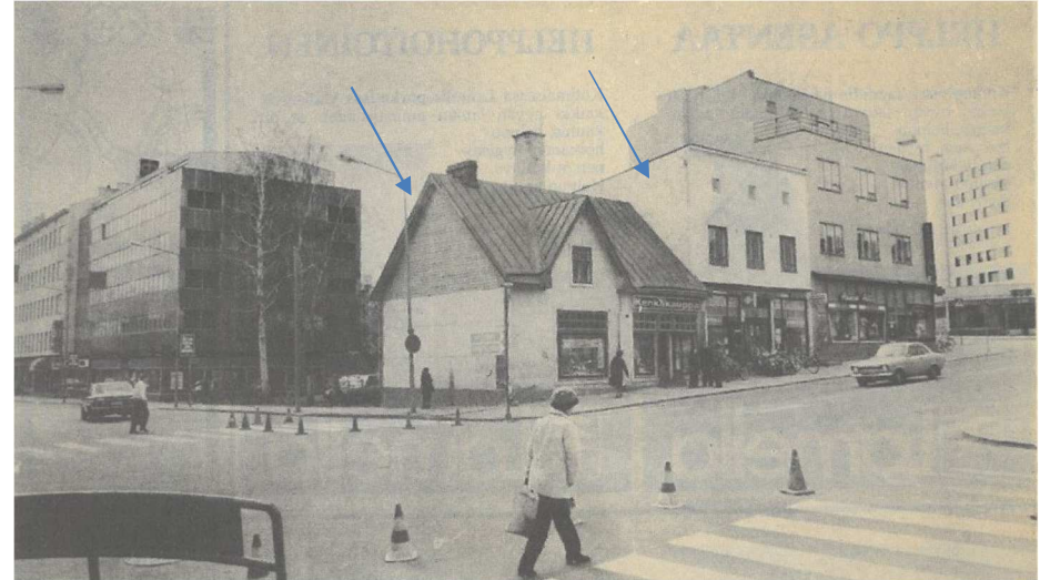
Kuva: Pankinkulman liikeytalon paikalta purettiin kuvassa näkyvät kaksi pienehköä liikeyrakennusta, joiden pääjulkisivut näyteikkunoinen olivat Hämeenkadun puolella. Puutaloa oli lyhennetty Keskuskadun puoleisesta päädyistä 1963. 3 /Kotikaupunki nro 1/82.
