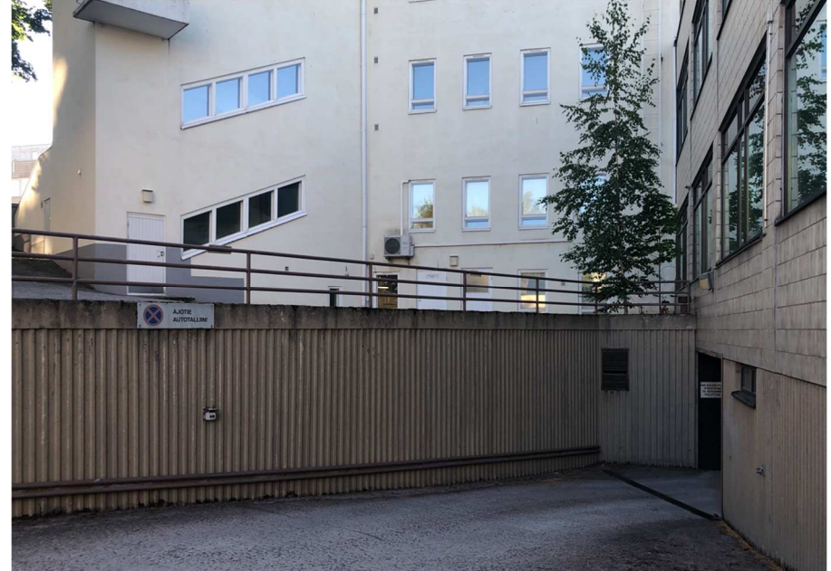
Kuva: Ajotie kellarikerroksen autopaikoille. Taustalla näkyy Mäkelän funkistalo. /Kuvaaja Tapio Sillfors 2022.
