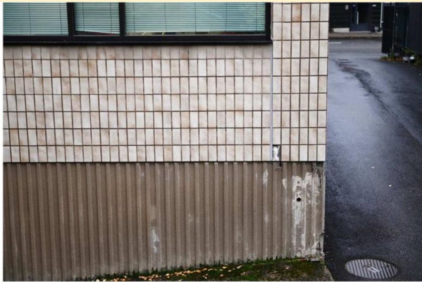
Kuva: Julkisivut ovat kauttaaltaan verhoiltu vaalein klinkkerein. Sisäpihan puolella korkeaksi nousevan sokkelin pinta on pystyuritettu ja maalattu.
