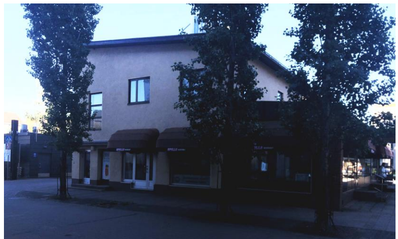
Kuva 2. Asuinliikerakennus tontin taka-osassa Granitin aukion puolella.
