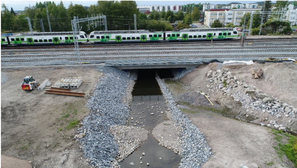
Kuva 4. Vuonna 2019 Riihimäen ratasillan uusimisen yhteydessä toteutettu uoman kunnostus alivirtaamakaudella.
