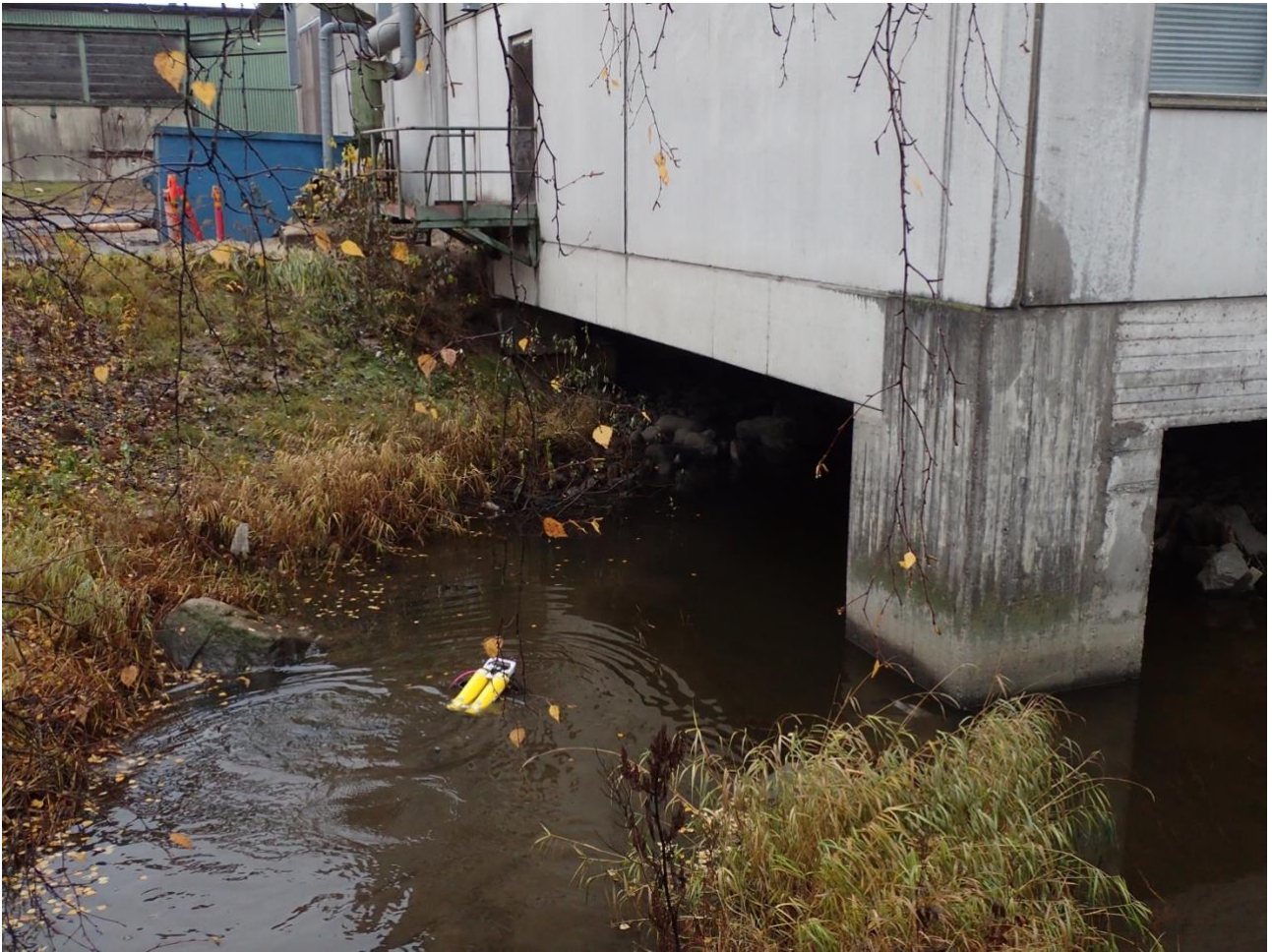
Kuva 3. Kulmalan Puistokadun putkisilta rajoittuu alavirran puolella Versowoodin kiinteistöön.
