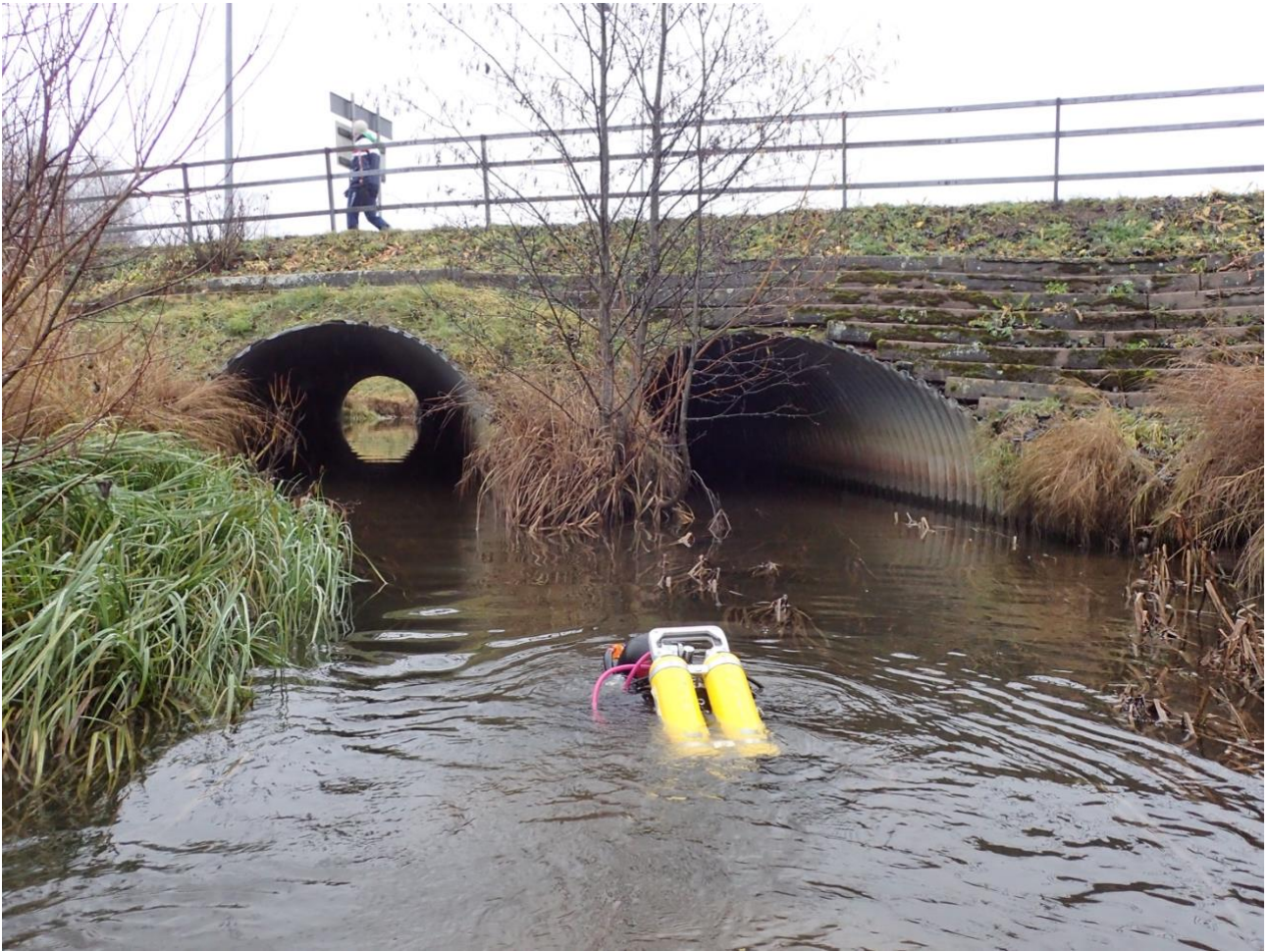
Kuva 4. Eteläisen Asemakadun putkisilta alavirrasta nähtynä.
