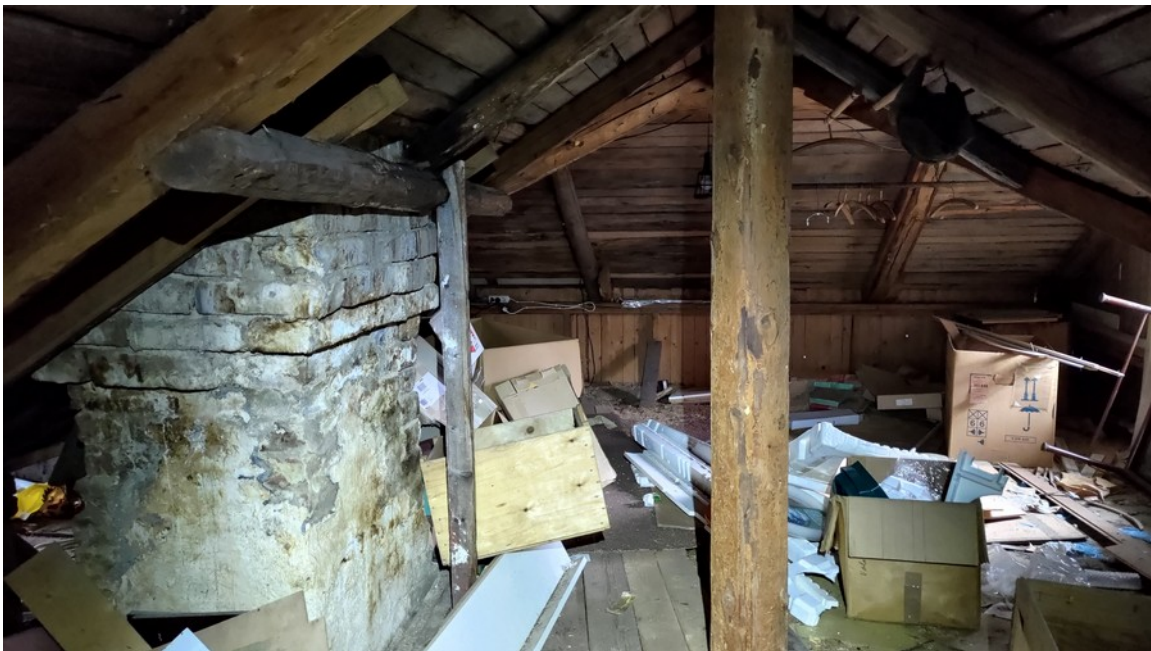
Kuva 6. Kaivokatu 8a päärakennuksen vinttiä.
