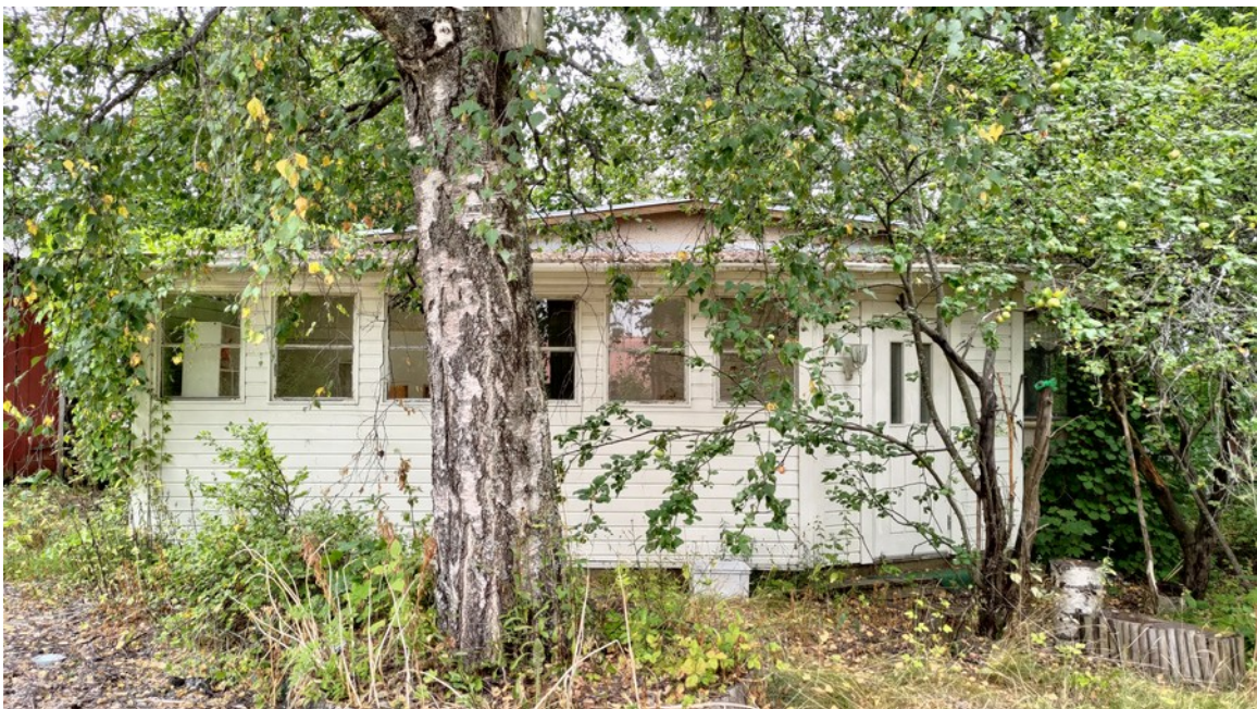
Kuva 4. Kaivokatu 6a:n vaalea piharakennus
