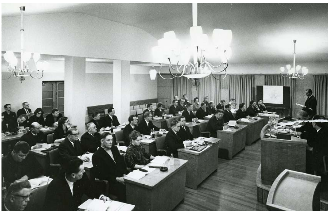
Kuva 23. Valtuustosali vuoden 1965 jälkeen, kun lämpiö on yhdistetty saliin ja lautalattia muutettu parkettilattiaksi. Vaneripintainen takaseinä on purettu ja ikkunaseinien vaneripinta peitetty verhoilla. Kuva Riihimäen kaupunginmuseo.
