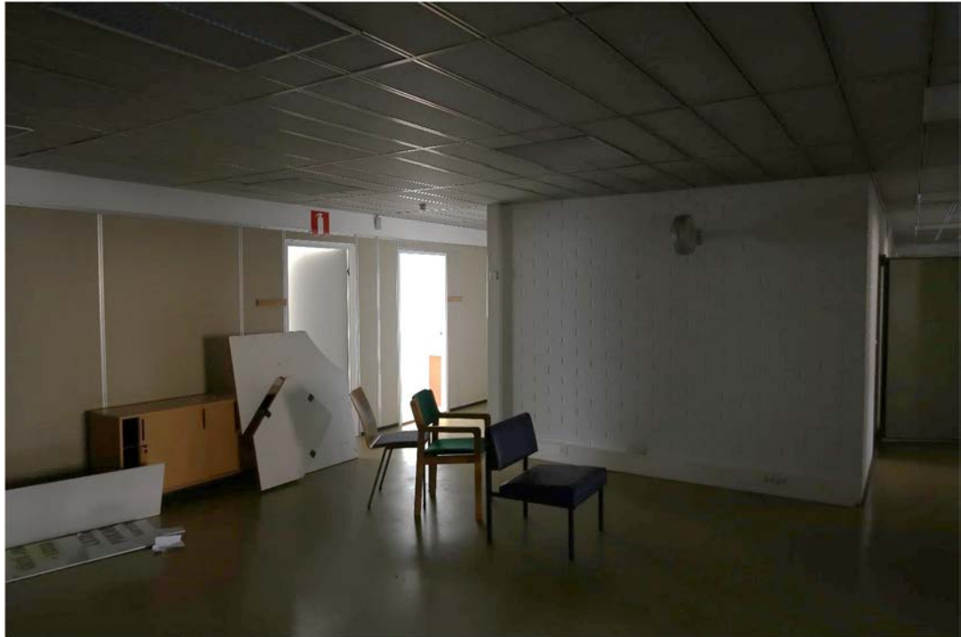
Kuva 27. Toisen kerroksen aula keskellä runkoa on hämärä. Kuva vuodelta 2020.
