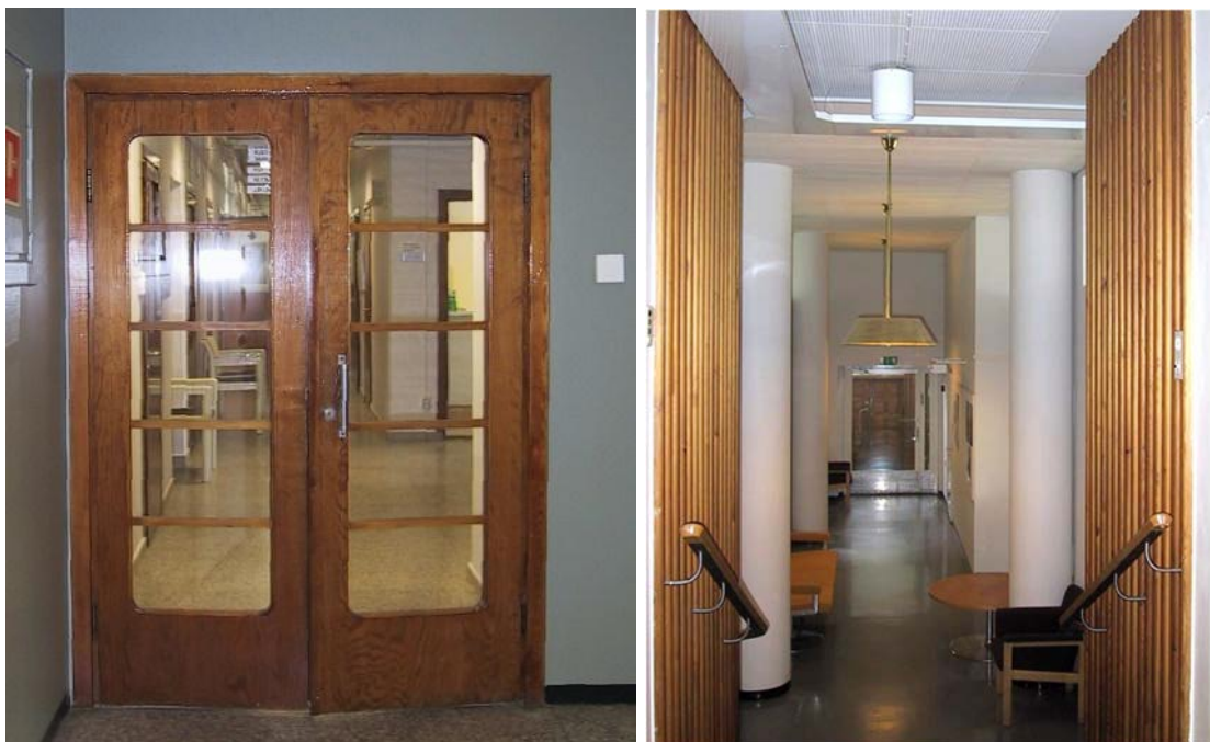
Kuva 16. Vasemmalla alkuperäinen ovi porrashuoneen ja toimistokäytävän välillä. Porrashuoneen ovet on korvattu vuoden 2003 korjauksessa teräslasipalo-ovilla. Oikealla kuva kohti alkuperäistä kirjastosalia, jonka lattiapintana on sama mosaiikkibetoni kuin käytävällä. Mosaiikkibetoni on korvattu vuoden 2003 korjauksessa parketilla. Kuvat vuodelta 2001, Teknisen Palvelukeskuksen arkisto.
