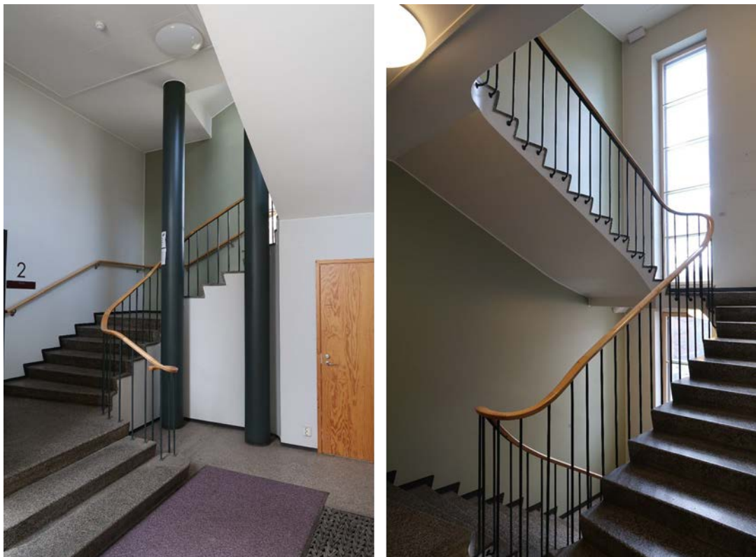
Kuva 45. Porrashuoneet ovat säilyttäneet piirteensä hyvin, tosin ovet portaikkoihin on uusittu viimeistään vuoden 2003 korjaustöiden yhteydessä. Vasemmalla kirjaston portaikko ja oikealla virastoportaikko.
