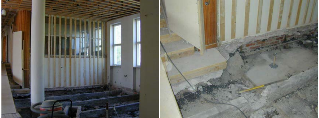
Kuva 34. Kirjastotilan alkuperäiset lasiseinät olivat vuoden 2003 korjauksen alkaessa jäljellä levytysten alla. Kirjastosalin välipohja avattiin myös kokonaan 2003 ja sen täytteet uusittiin. Kuvat Arkjaatiset Oy.
