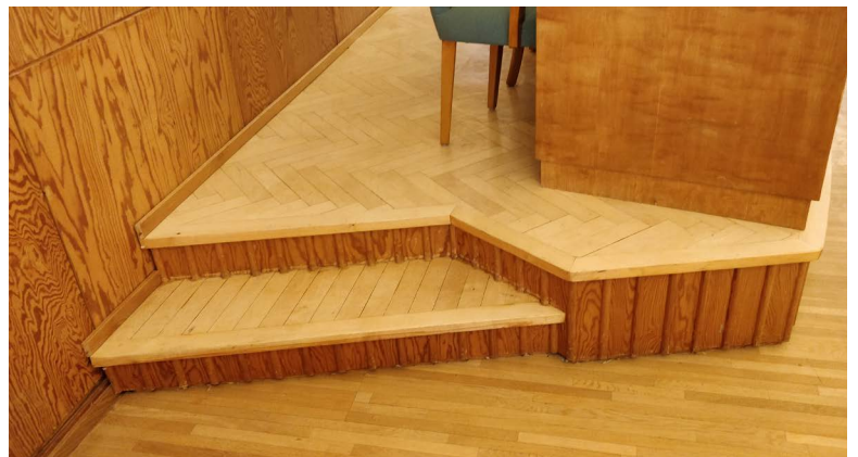
kuva 14: panelointia seinässä ja korokkeessa
