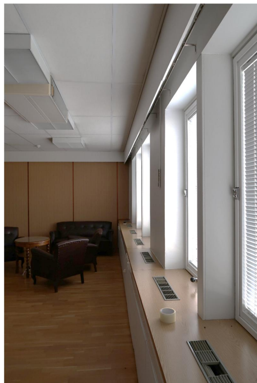
Kuva 14. Konvektorikotelon piirustus sekä valokuva siitä, miten tuloilmasäleiköt ovat ikkunapenkkien pinnassa.
