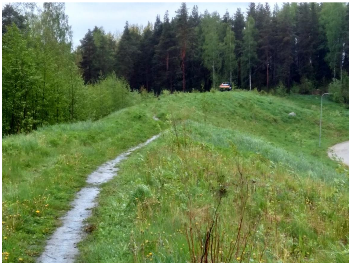
Kuva 12. Yleiskuva Tiilikadun vallista ennen muokkaustöitä 26.5.21 (Kulhoranta 2021).
