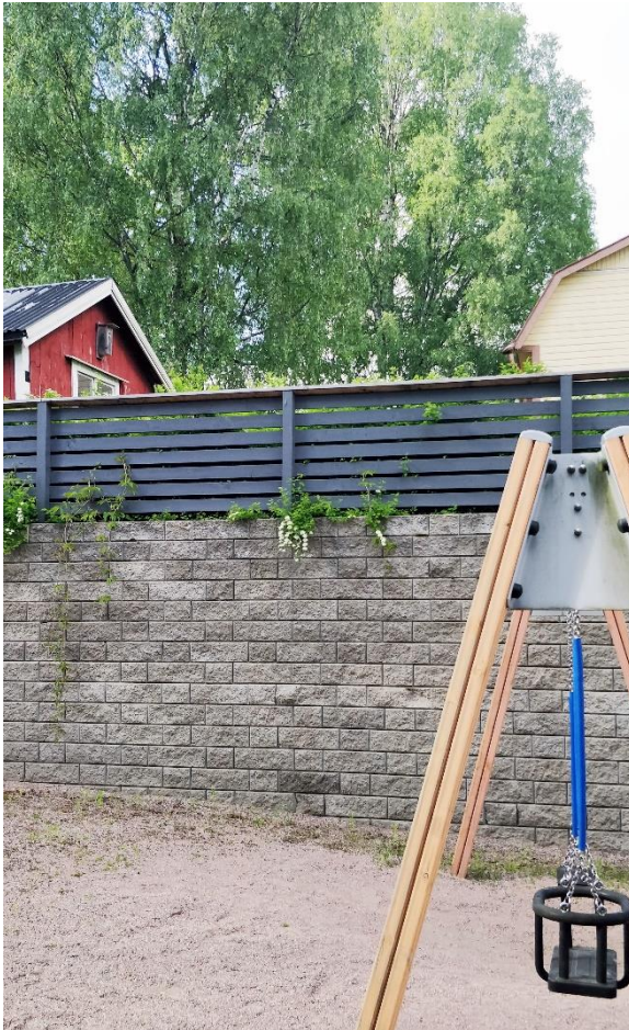
Naapurin pihamuuri, jonka takana on asemakaava-alueen maanpinta korkeimmillaan. Tässä kohdassa olisi hyvä mahdollisuus pienentää korkeuseroa.
