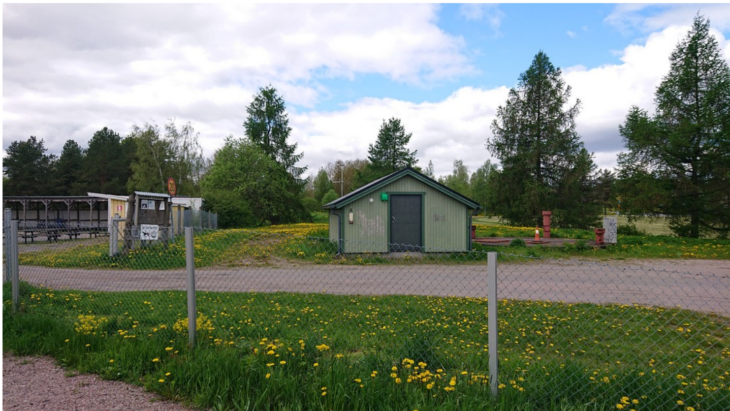
Liitekuva rakennuksesta 14. Pumppukoppi.
