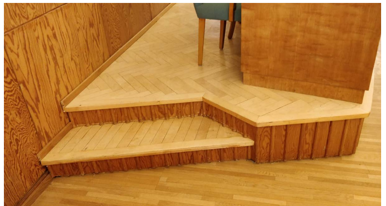
kuva 14: panelointia seinässä ja korokkeessa
