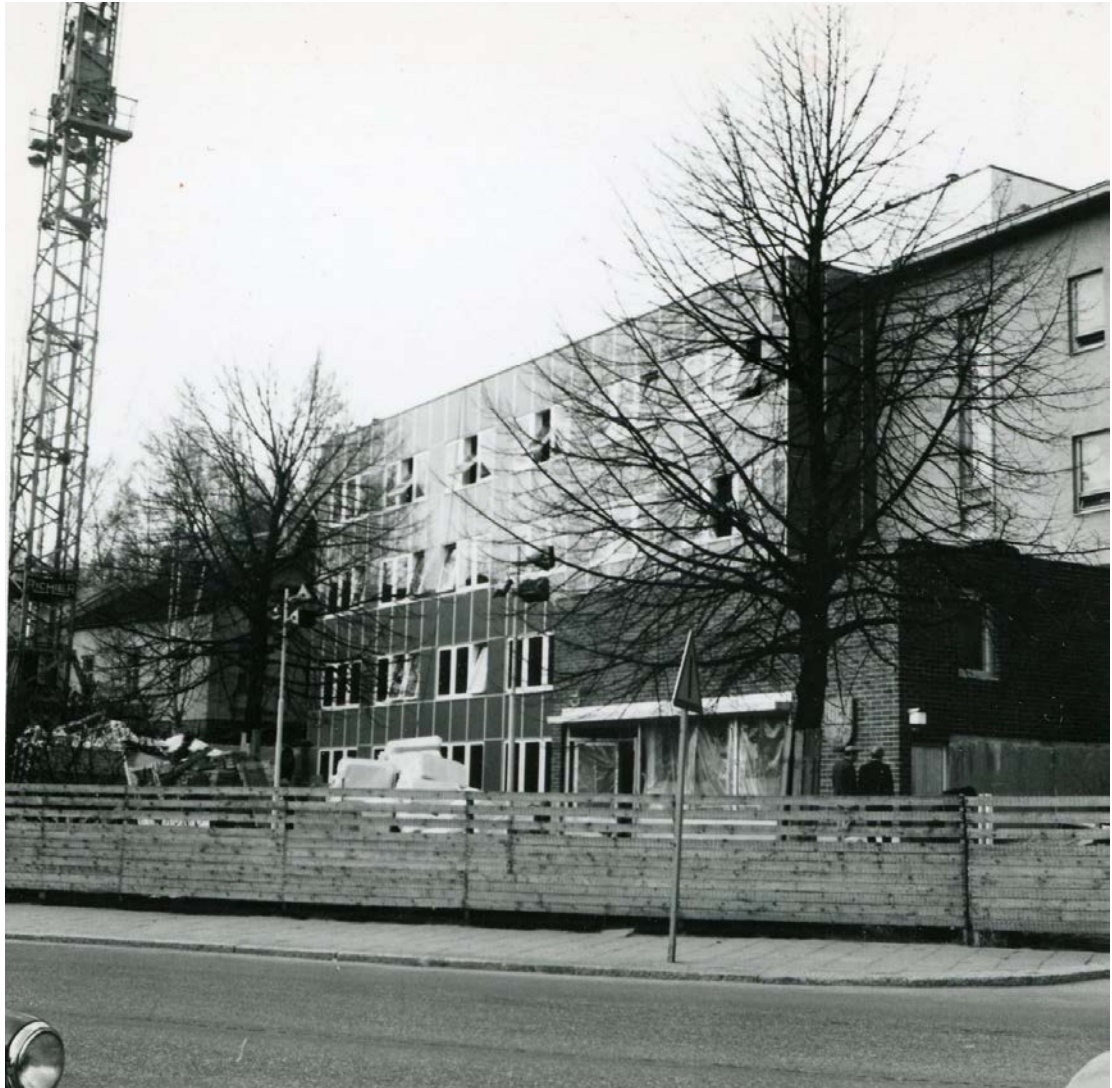
Kuva 25. Laajennusosa rakenteilla. Kuva Riihimäen kaupunginmuseo.
