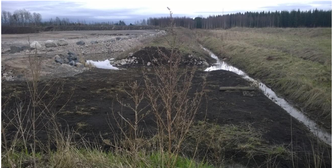
Kuva 7. Oikealla purkupisteeseen 1 johtava oja ja vasemalla rakenteilla olevaa tonttia sekä rakenteilla oleva hulevesiallas
