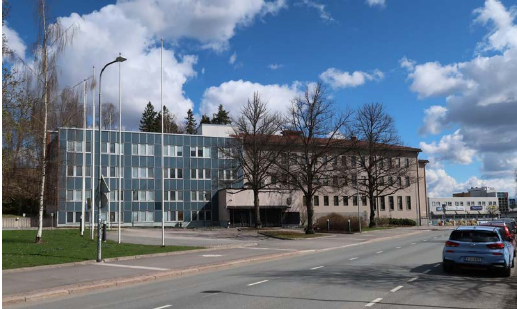
Kuva 2. Vanha ja uusi osa. Vanha osa on rapattu ja uudessa on lasijulkisivu. Niitä yhdistävä eteisaula oli alun perin tiilipintainen, mutta rapattiin vuonna 2003.
