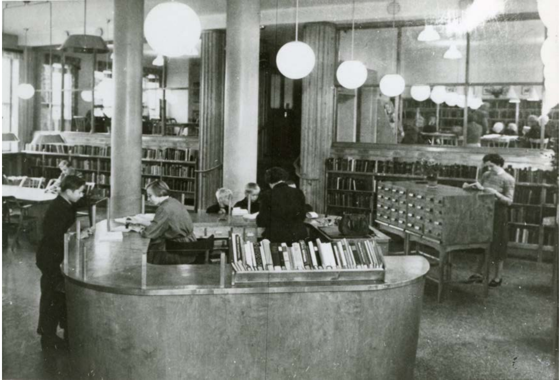
Kuva 13. Kirjasto alkuperäisessä asussaan n. vuonna 1950. Korkeasta tilasta on ikkunaseinät matalampiin tiloihin käytävän varrella kuten yllä olevassa projektiossa on kuvattu. Kuva Riihimäen kaupunginmuseo.
