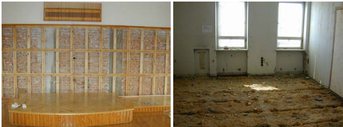
Kuva 35. Vuoden 2003 peruskorjaus oli perusteellinen. Vasemmalla valtuustosalin etuseinä, jonka vaneripinta on irrotettu kunnostusta varten. Oikealla alalaattapalkistovälipohjan täytteet esillä ennen niiden poistamista. Kuvat Arkjaatiset Oy.
