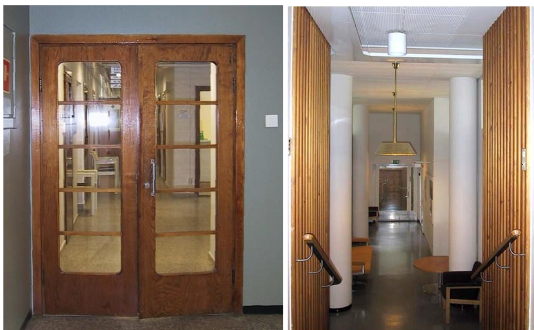
Kuva 16. Vasemmalla alkuperäinen ovi porrashuoneen ja toimistokäytävän välillä. Porrashuoneen ovet on korvattu vuoden 2003 korjauksessa teräslasipalo-ovilla. Oikealla kuva kohti alkuperäistä kirjastosalia, jonka lattiapintana on sama mosaiikkibetoni kuin käytävällä. Mosaiikkibetoni on korvattu vuoden 2003 korjauksessa parketilla. Kuvat vuodelta 2001, Teknisen Palvelukeskuksen arkisto.
