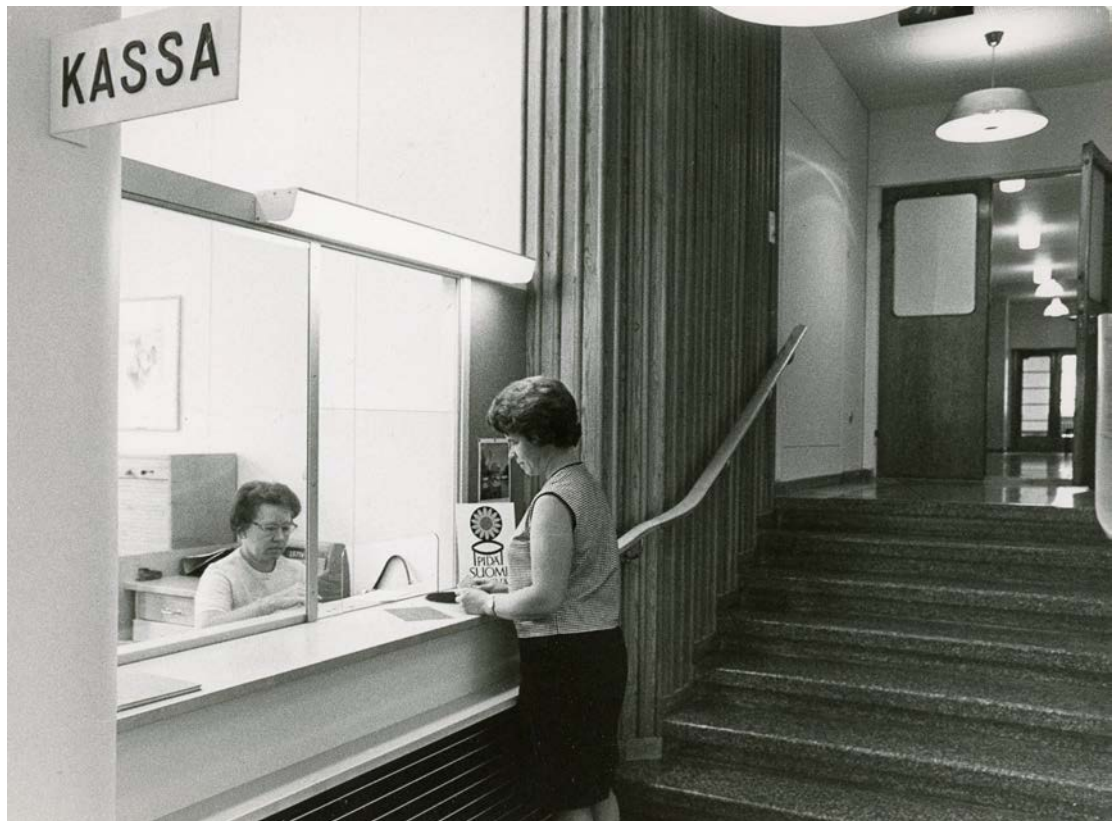
Kuva 19. Kirjastosta rahatoimistoksi muutettu korkea tila ensimmäisessä kerroksessa. Korkeasta tilasta matalampaan avautuneet ikkunat on ummistettu ja väliseinä tiskeineen rakennettu korkeaan tilaan. Kuva Riihimäen kaupunginmuseo.
