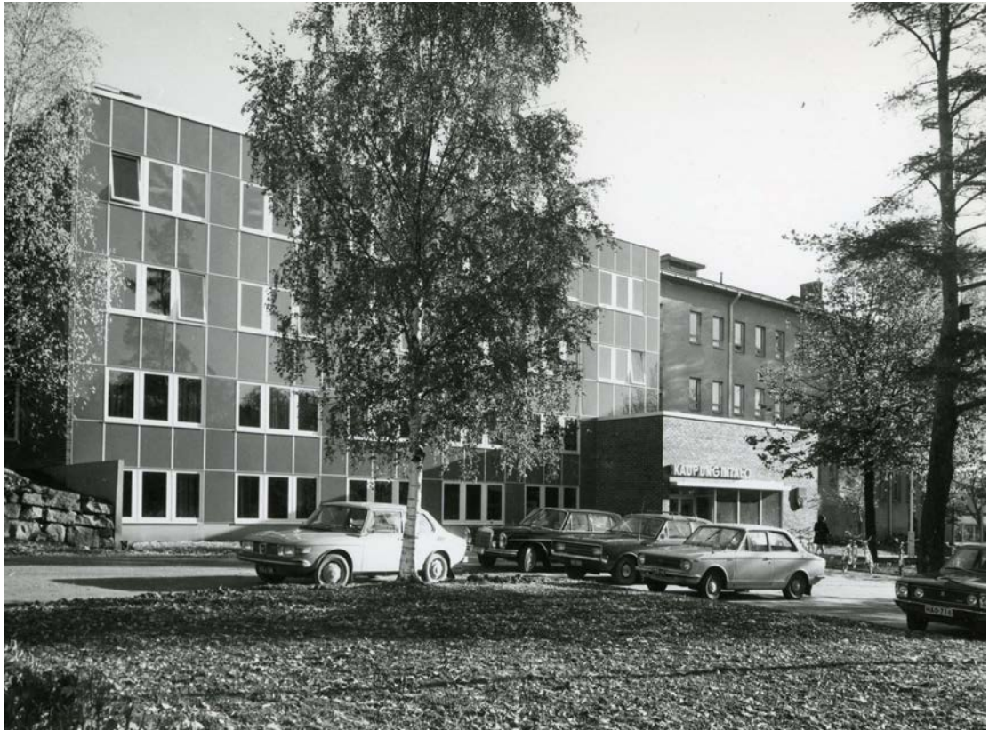
Kuva 26. Laajennusosan julkisivun sommittelu perustuu tasaiseen ruudukkoon. Eteisaula oli alun perin puhtaaksi muurattu tiiltä samaan tapaan kuin päädyn porrashuoneen seinät. Sisäntuloaulan julkisivut rapattiin vuonna 2003. Kuva Riihimäen kaupunginmuseo.
