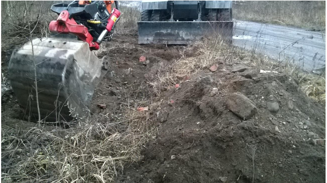
Kuva 5. Tutkimuspiste B10. Pintamaassa tiiliä.
