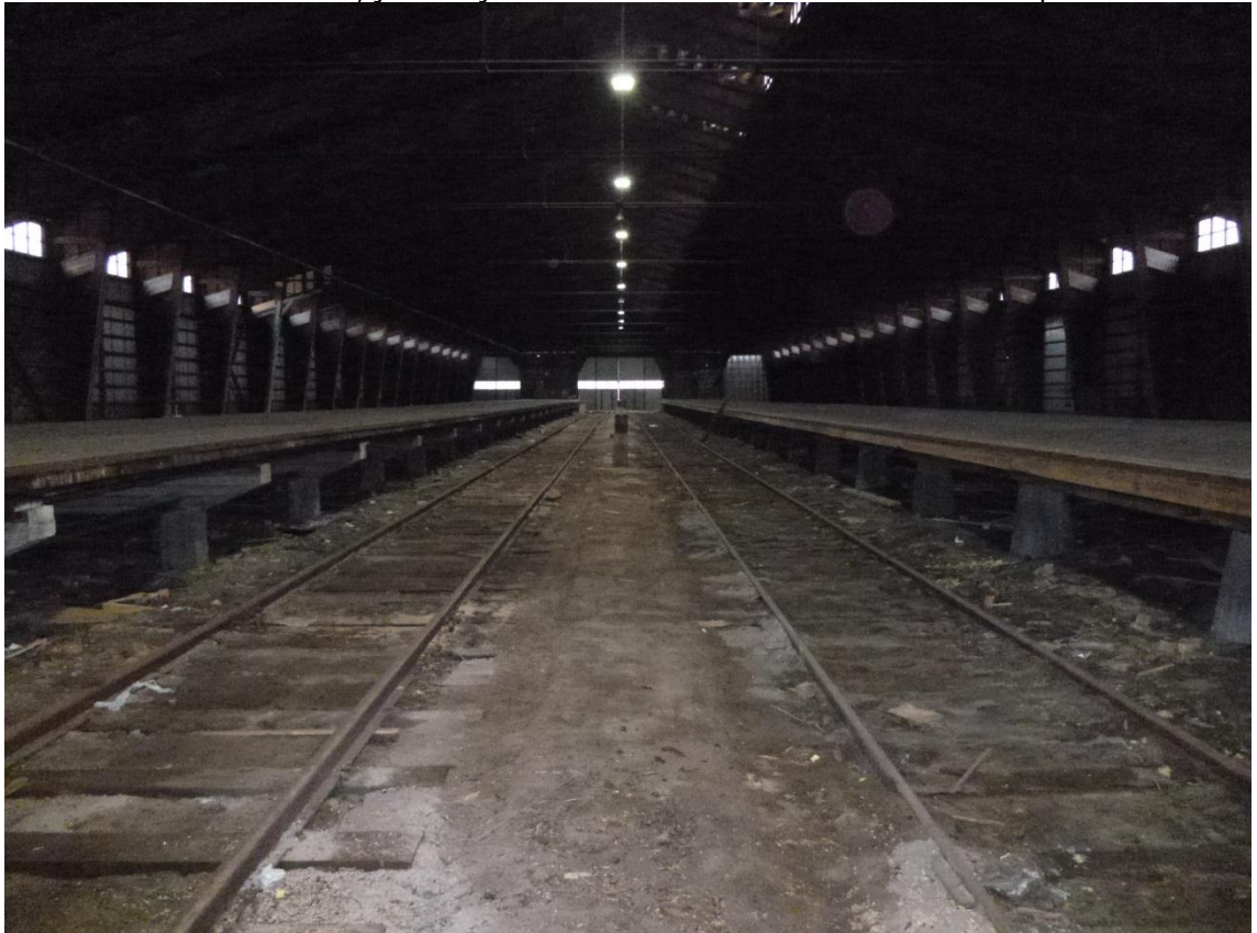
Kuva 4. Junien huoltohalli, johon sijoitettiin S-tunnuksella merkatut tutkimuspisteet.
