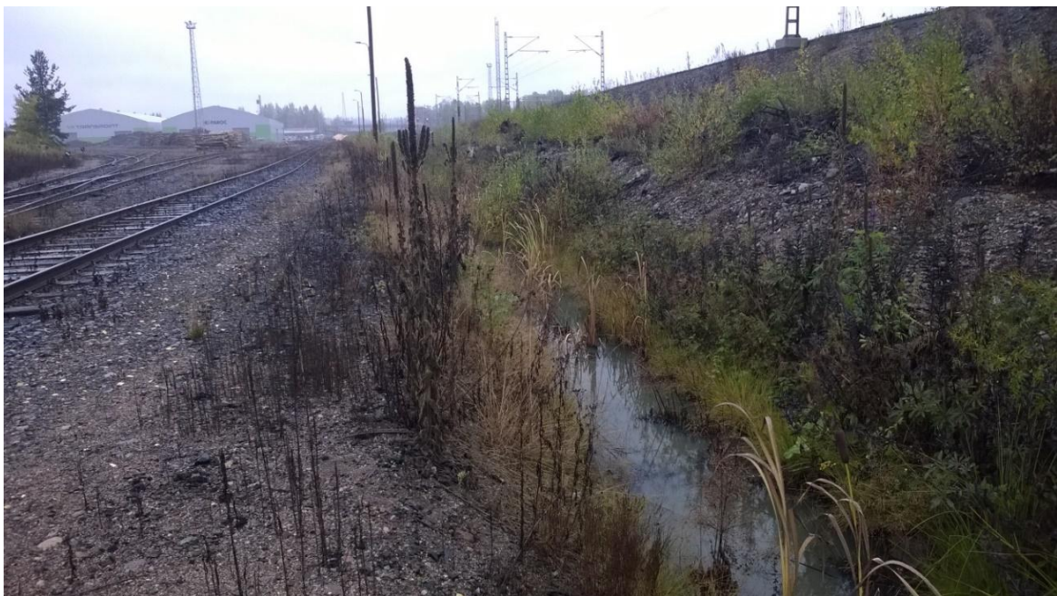
Kuva 10. Rata-alueen kuivatusoja johtaa kuvan 6 ottoputkeen [Ramboll 10/2017]
