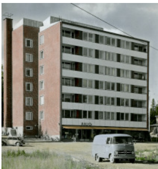
Asunto Oy Otsolan Etelätorni v. 1963, Teräskiilakokoelma.
