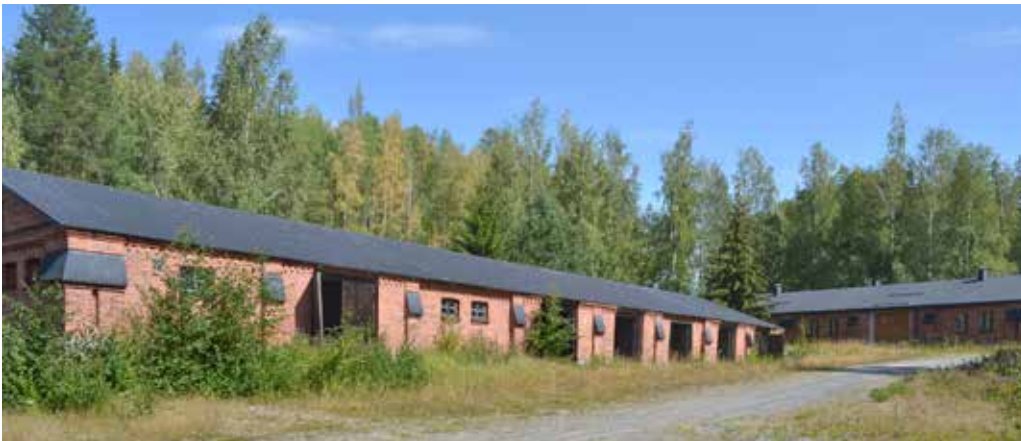
68 ja 69, entiset autotalli- ja varastorakennukset
