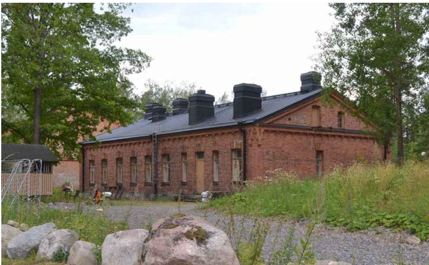
76, entinen venäläinen upseerirakennus
