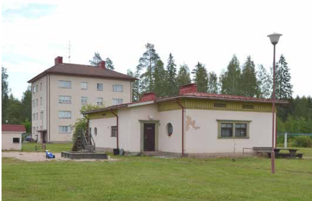
91, sauna- ja pesutupa- rakennus
