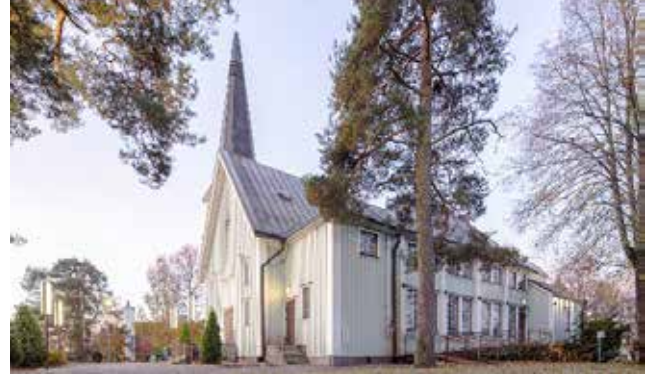
Riihimäen vuonna 1905 rakennettu keskuskirkko on kirkkolailta suojeltu. Kuva: Juho Haavisto.
