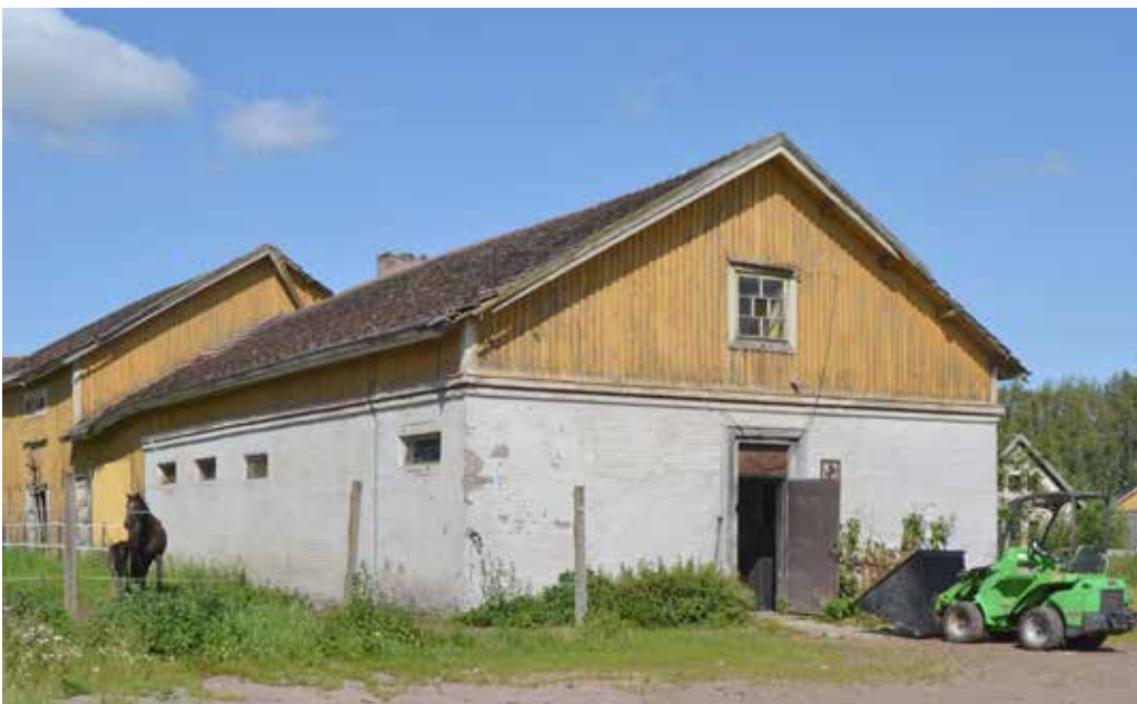
94, Sammaliston tila, tallirakennus, 1931
