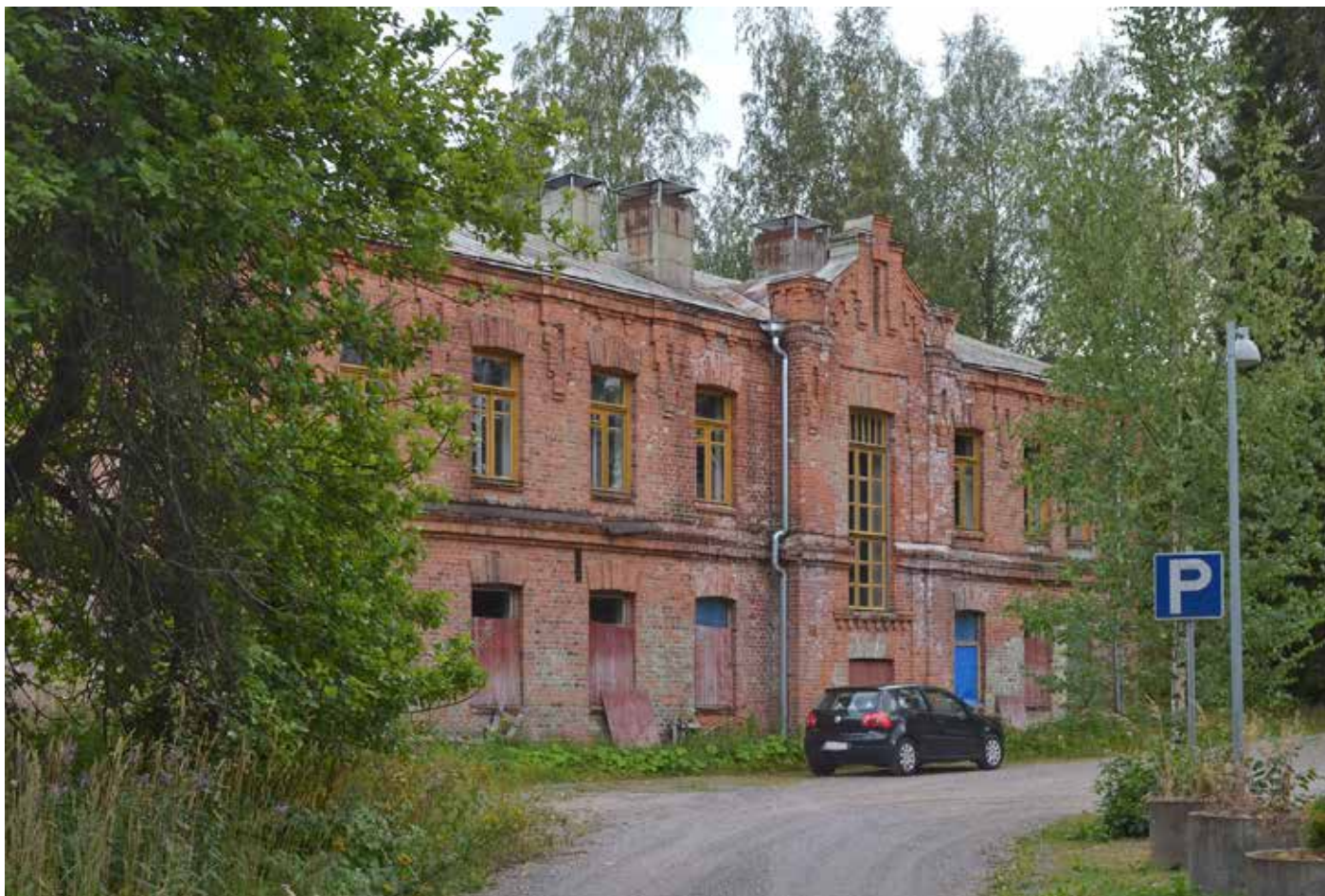
75, entinen venäläinen upseerirakennus
