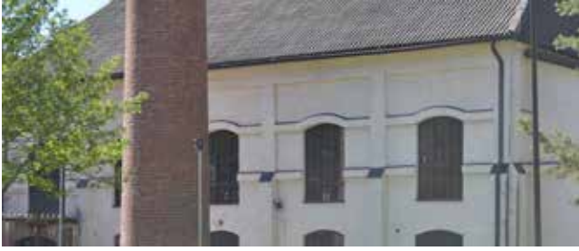
Riihimäen Lasin entinen alalastehdas rakennettiin alun perin Polttoturve Oy:n rakennukseksi 1914. Rakennus kunnostettiin Suomen Lasimuseon käyttöön 1980-luvun alussa.
